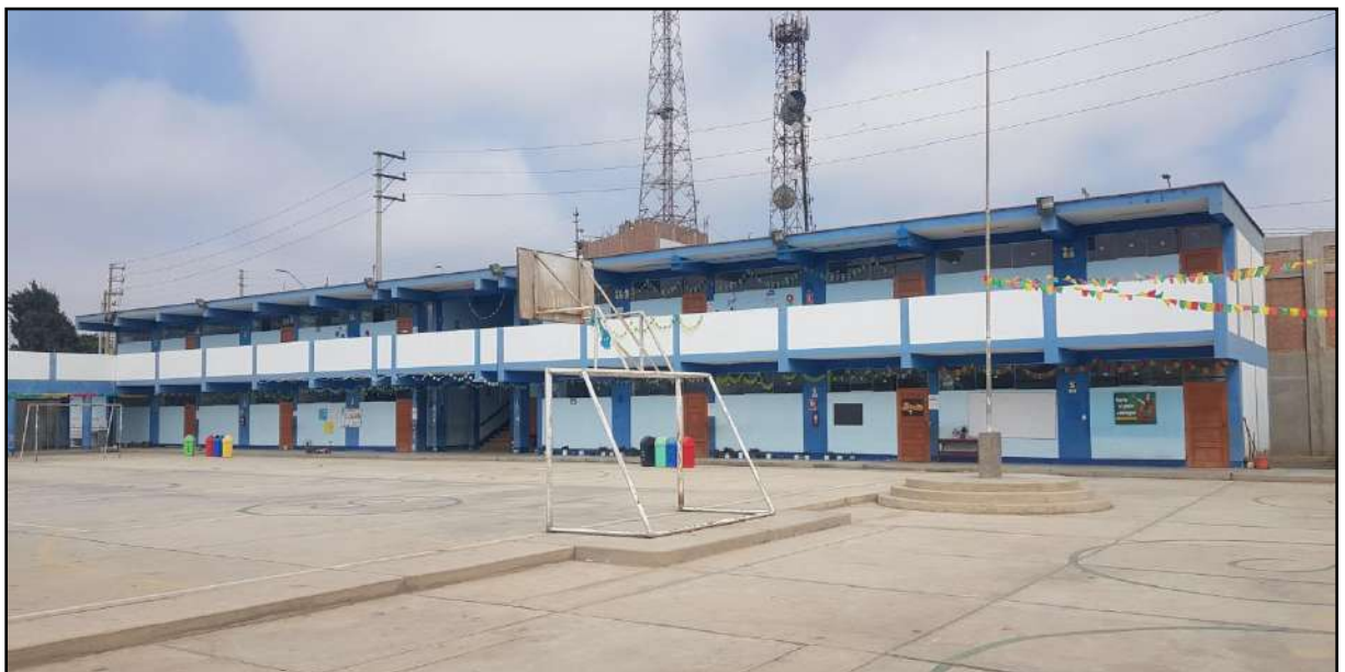
Figura 5. Estado del Pabellón 1 y 2 de la I.E. Luis Alberto Sánchez.
