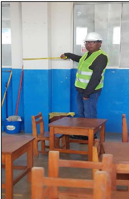
Figura 7. Medición de elementos estructurales en el Pabellón 1 y 2.
