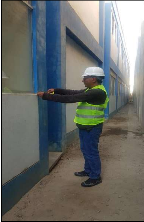
Figura 6. Medición de elementos estructurales en el Pabellón 1 y 2.
