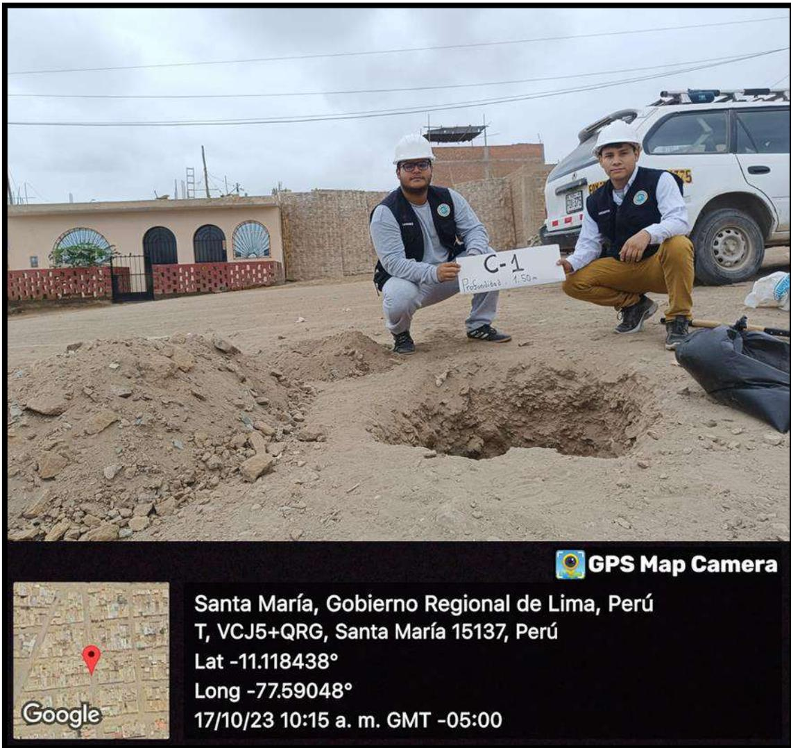
*Figura 13. Excavación calicata C-1*
