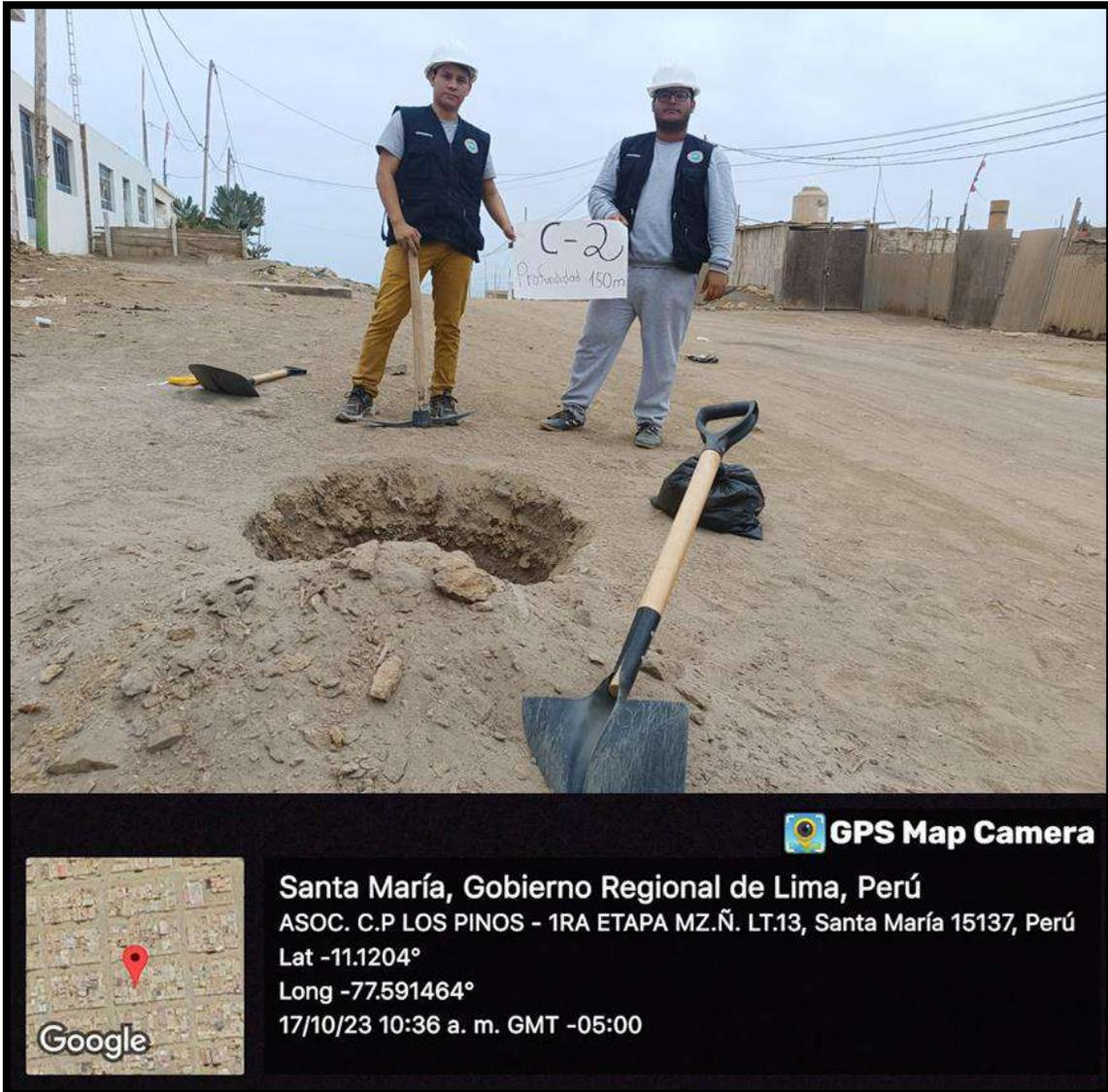
Figura 12. Excavación calicata C-2
