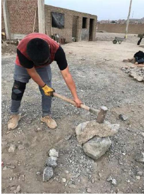
**Foto 03.** Trituración manual del concreto reciclado
