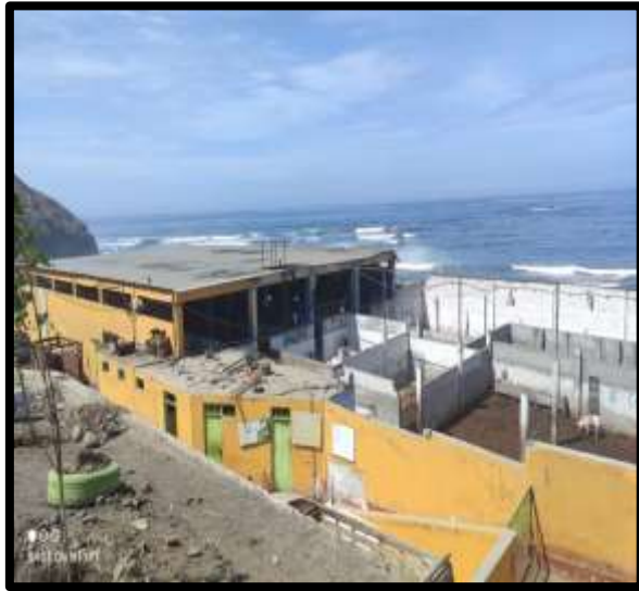
Figura 7. Camal Municipal de la Provincia de Barranca, establecimiento en donde sacrifican animales para su posterior almacenamiento y comercialización.
