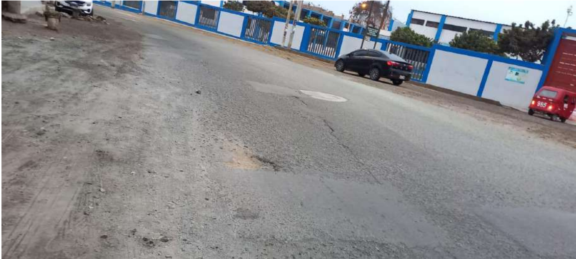
Figura 63: Falla de Huevo y Piel de cocodrilo en la muestra N° 05
