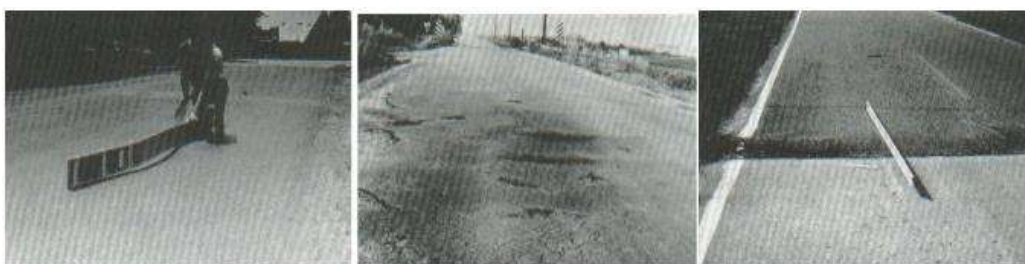
Figura 22: Desplazamiento de severidad baja, media y alta (izquierda a derecha)
