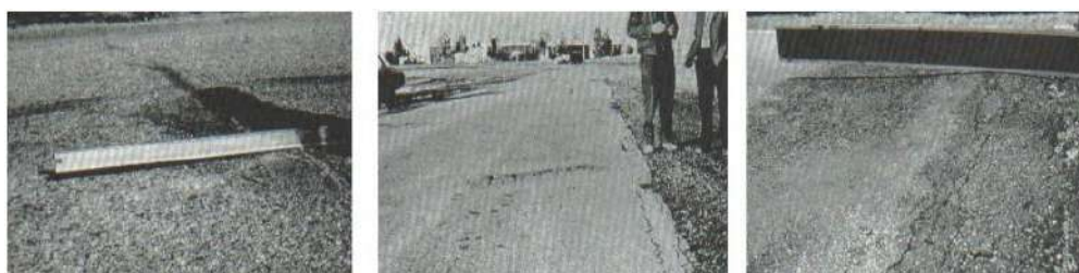
Figura 10: Abultamientos y hundimientos de severidad baja, media y alta (Izquierda a derecha).
