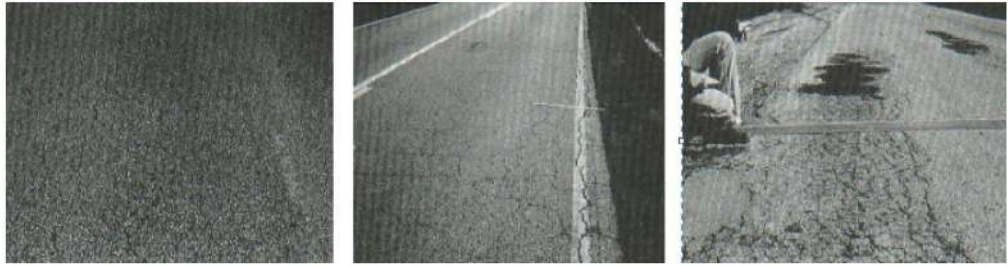
Figura 7: Piel de cocodrilo de severidad baja, media y alta (izquierda a derecha).
