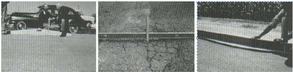
Figura 12: Depresión de severidad baja, media y alta (Izquierda a derecha).
