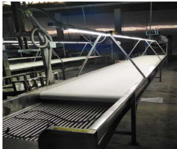
Figura 15. Faja transportadora de las líneas
