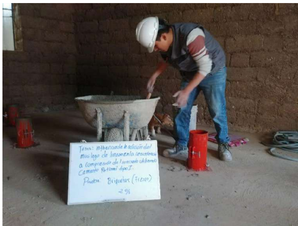
Figura 24: Llenado y elaboración de probetas de concreto. Fuente: Autor
