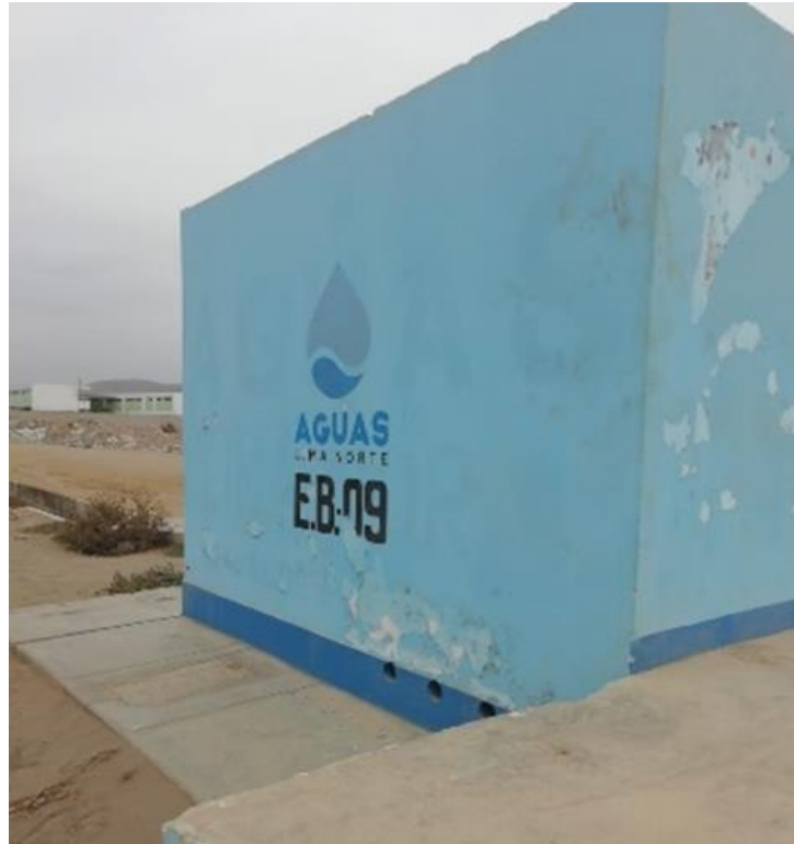
Figura 7: Fachada de la captación - Punto P 09 Baltazar la Rosa Fuente: Autoría Propia, 2022
