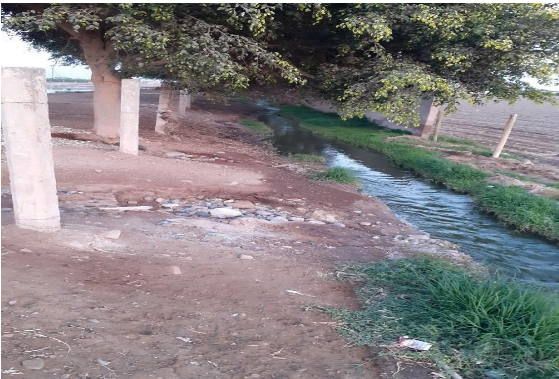
Figura 4: Recorrido de las aguas servidas provenientes de las pozas de oxidación hacia los campos
