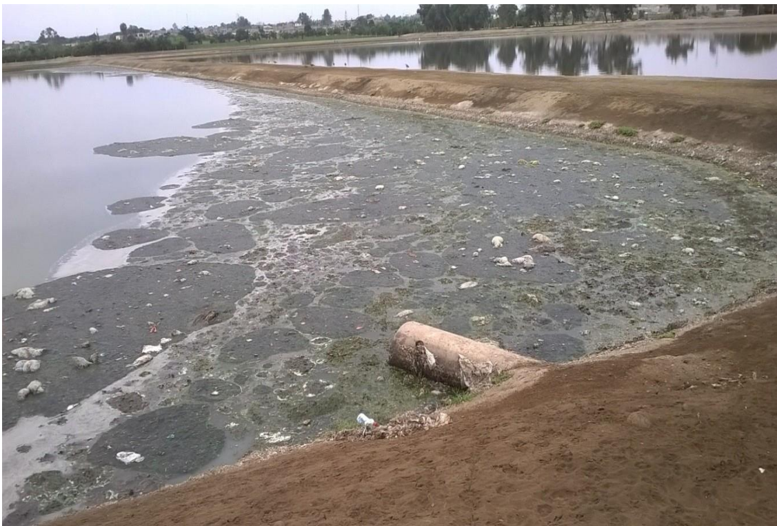
Figura 2: Vista de poza de Oxidación
