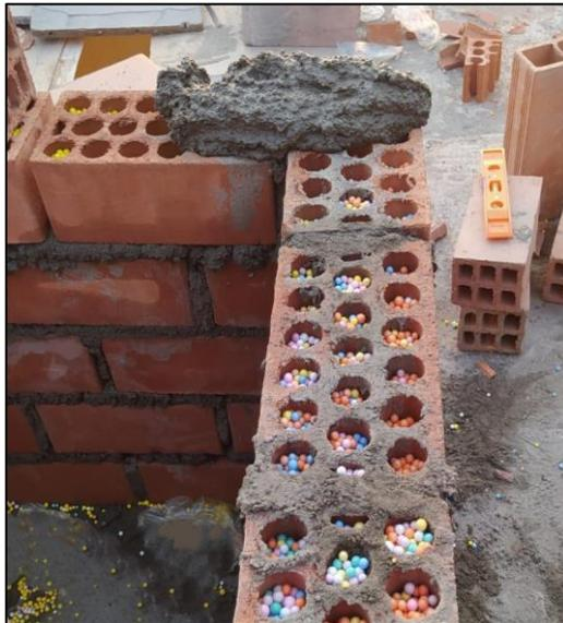
Fotografía 23: Prototipo Modificado - Incorporación de perlas de tecnopor en los ladrillos
