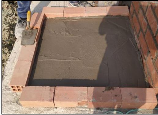
Fotografía 22: Módulo de losa armada para el techo de los prototipos
