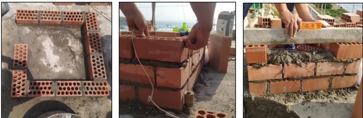
Fotografía 19, 20 y 21: 1er emplentillado, verificación mediante la plomada, nivelación de ladrillos
