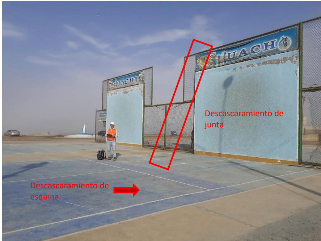
ANEXO 10. Descascaramiento de esquina, descascaramiento de junta, grieta de esquina y parcheo grande
