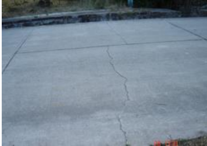
Figura 12. Grieta transversal
