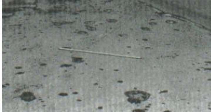
Figura 16. Popouts (desprendimientos)
