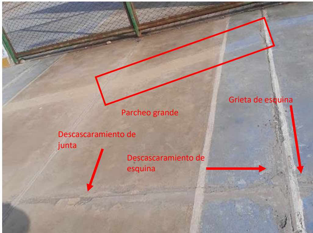
ANEXO 10. Descascaramiento de esquina, descascaramiento de junta, grieta de esquina y parcheo grande
