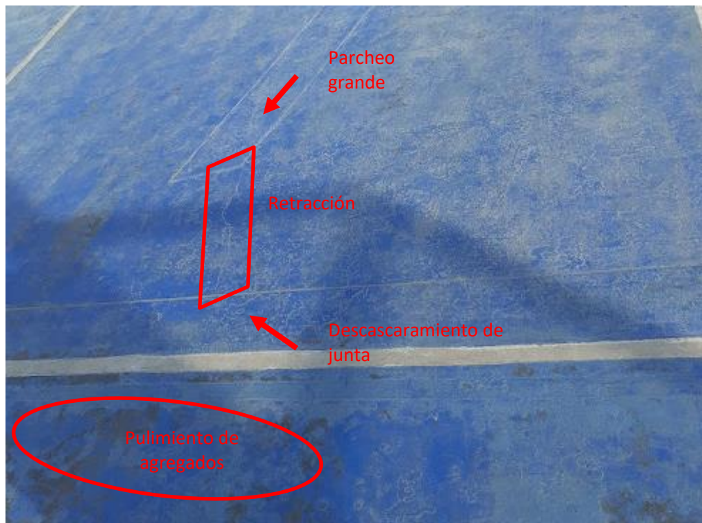
ANEXO 14. Pulimiento de mezclas, descascarillado de unión, resane grande.
