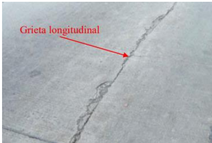
Figura 11. Grieta longitudinal
