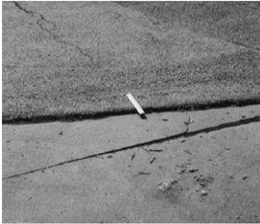
Figura 46 Grado de gravedad (M) - Desplazamiento.
