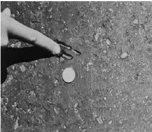
Figura 6 Grado de gravedad (M) - Exudación.
