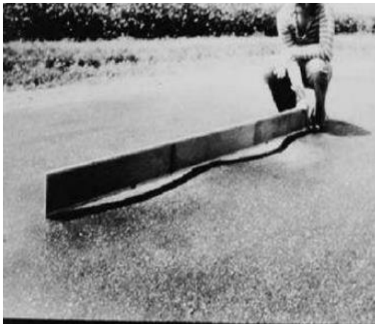
Figura 16 Grado de gravedad (H) - Corrugación.
