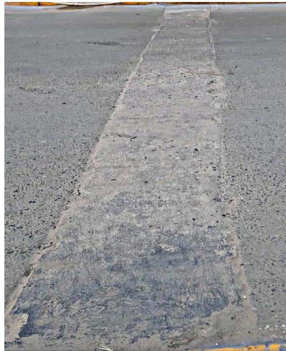
Fotografía 8 Identificación de tipo de falla parcheo, nivel de severidad bajo.
