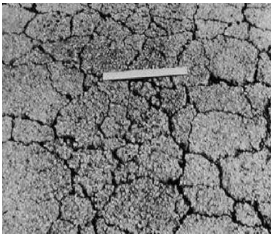
Figura 4 Grado de gravedad (H) - Piel de cocodrilo.
