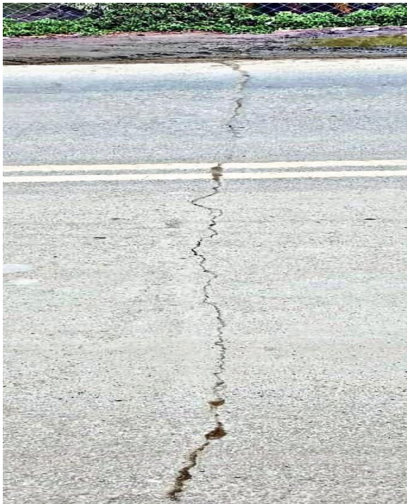
Fotografía 18 Identificación de tipo de falla grietas longitudinales y transversales, nivel de severidad medio.
