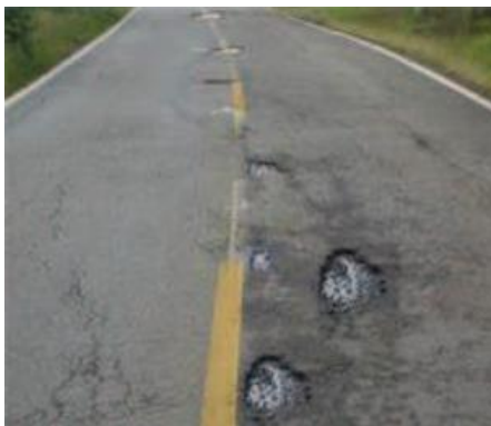
Figura 84 Nivel de gravedad (2) - Ojos de pescado.
