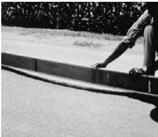
Figura 18 Grado de gravedad (M) – Depresión.
