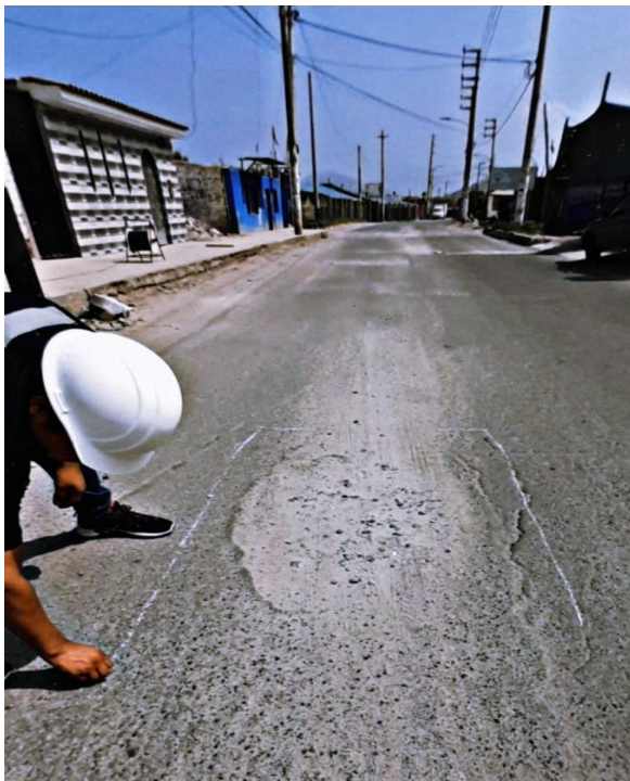
Fotografía 2 identificación y medición del tipo de falla parcheo, nivel de severidad alto y bajo.
