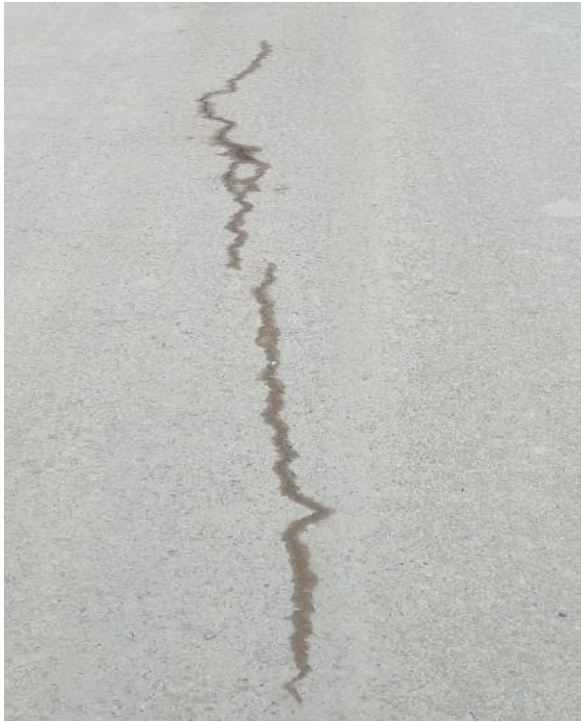
Fotografía 19 Identificación de tipo de falla grietas longitudinales y transversales, nivel de severidad medio.
