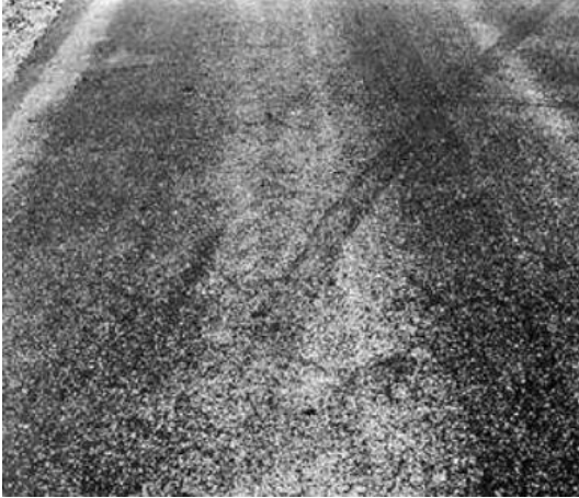
Figura 5 Grado de gravedad (L) - Exudación.
