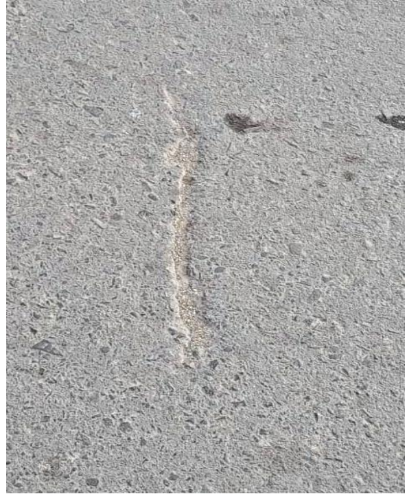
Fotografía 17 Identificación de tipo de falla grietas longitudinales y transversales, nivel de severidad alto.
