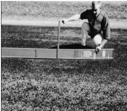
Figura 17 Grado de gravedad (L) – Depresión.
