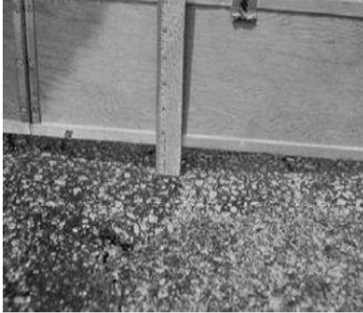
Figura 44 Grado de gravedad (H) - Ahuellamiento.
