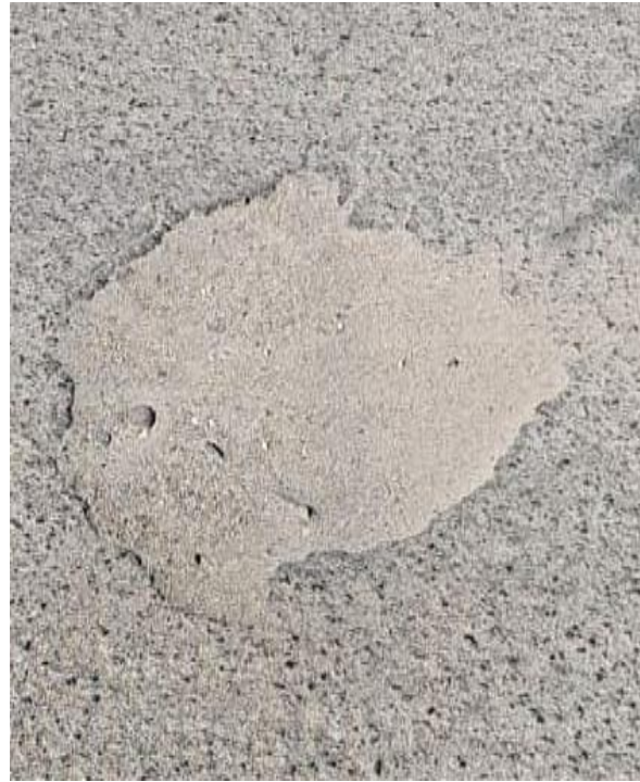
Fotografía 15 Identificación de tipo de falla hueco, nivel de severidad alto.
