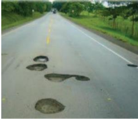
Figura 83 Nivel de gravedad (1) - Ojos de pescado.
