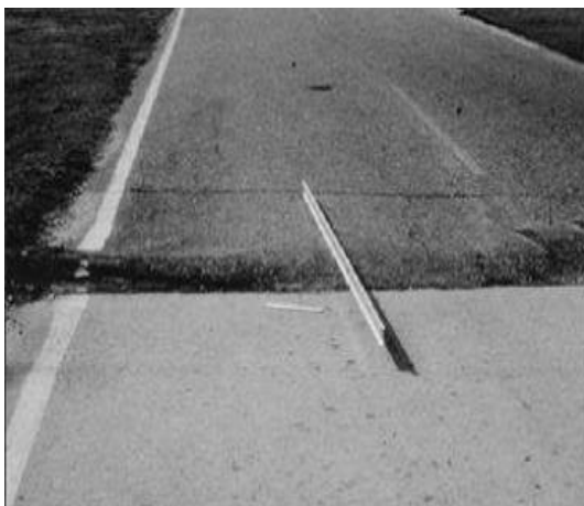
Figura 47 Grado de gravedad (H) - Desplazamiento.
