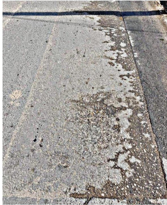
Fotografía 11 Identificación y medición de tipo de falla parcheo, nivel de severidad alto.
