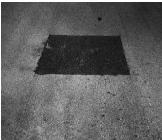
Figura 32 Grado de gravedad (L) - Parcheo.
