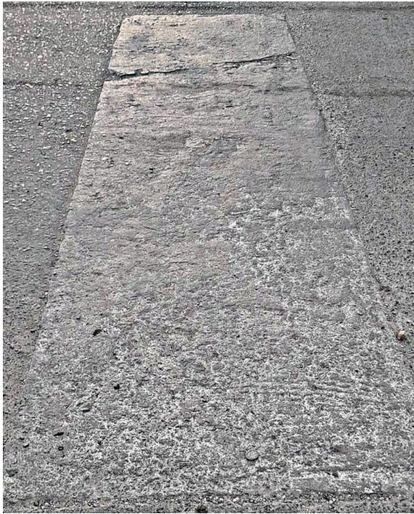
Fotografía 9 Identificación de tipo de falla parcheo, nivel de severidad bajo y medio.
