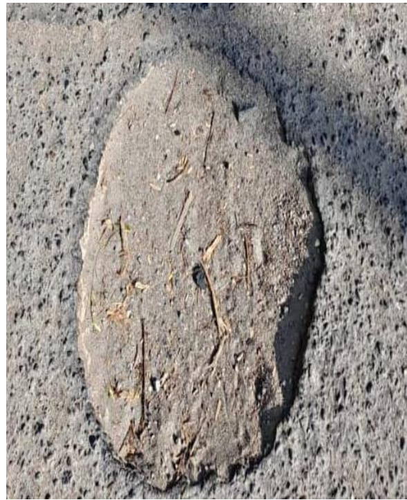
Fotografía 14 Identificación de tipo de falla hueco, nivel de severidad alto.
