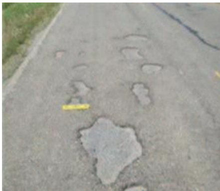
Figura 96 Nivel de gravedad (2) - Descascaramientos.
