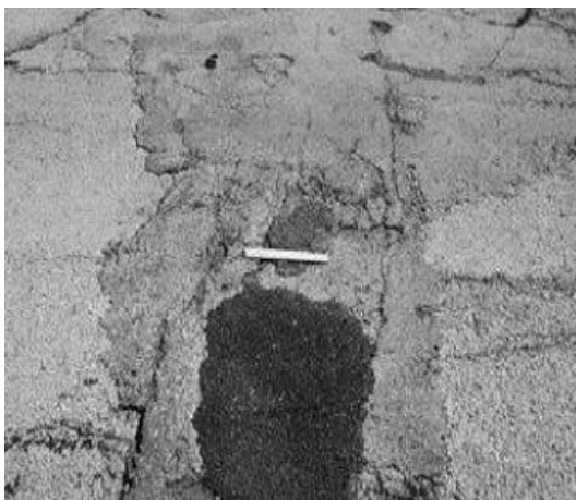
Figura 34 Grado de gravedad (H) - Parcheo.
