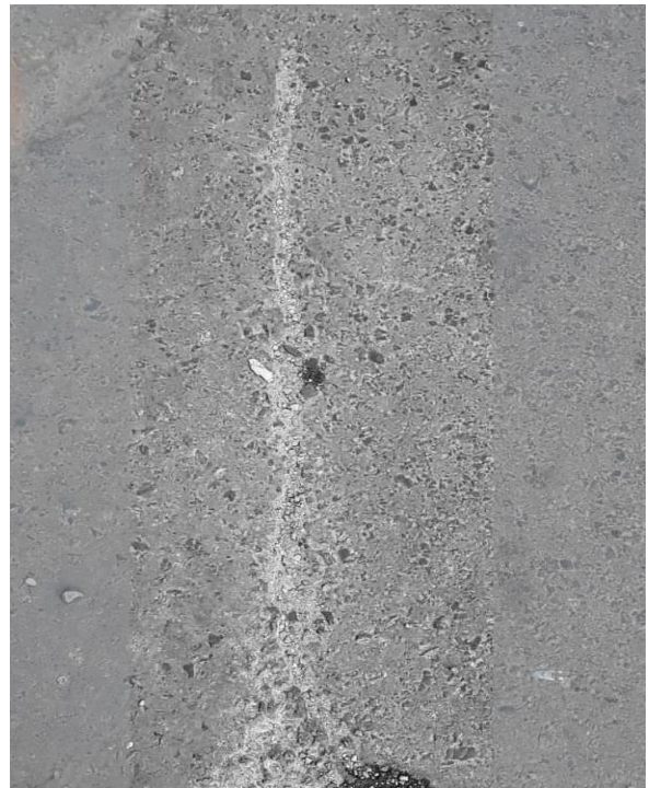
Fotografía 18 Identificación de tipo de falla grietas longitudinales y transversales, nivel de severidad medio.
