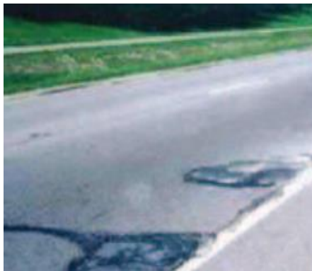
Figura 102 Nivel de gravedad (1) - Afloramiento de mortero.
