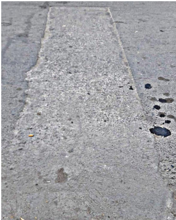
Fotografía 8 Identificación de tipo de falla parcheo, nivel de severidad bajo.
