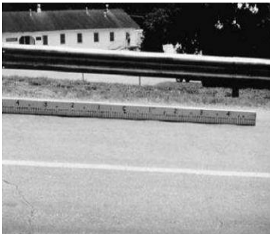
Figura 14 Grado de gravedad (L) - Corrugación.
