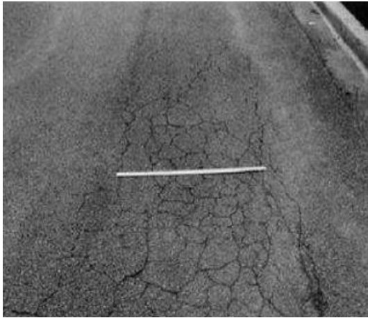
Figura 3 Grado de gravedad (M) - Piel de cocodrilo.
