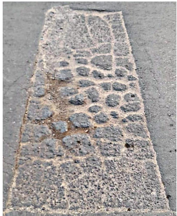
Fotografía 10 Identificación de tipo de falla parcheo, nivel de severidad alto.
