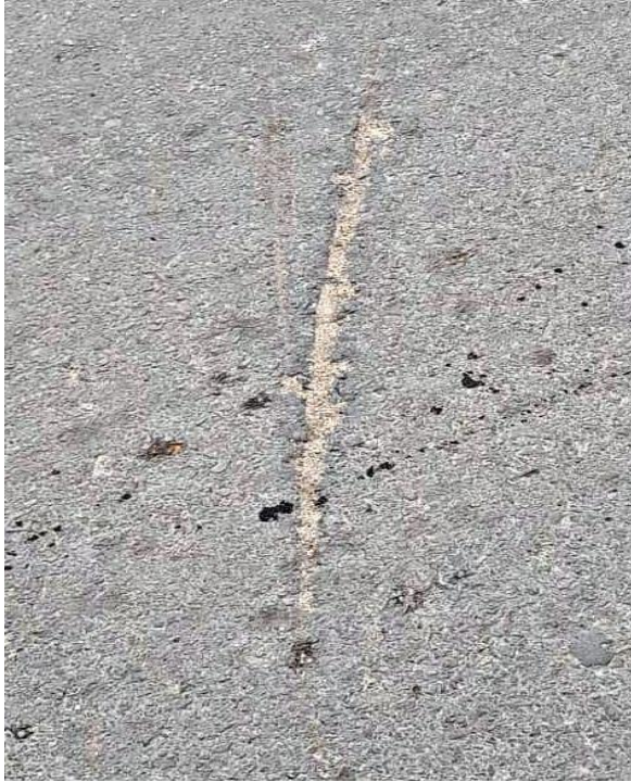
Fotografía 17 Identificación de tipo de falla grietas longitudinales y transversales, nivel de severidad alto.
