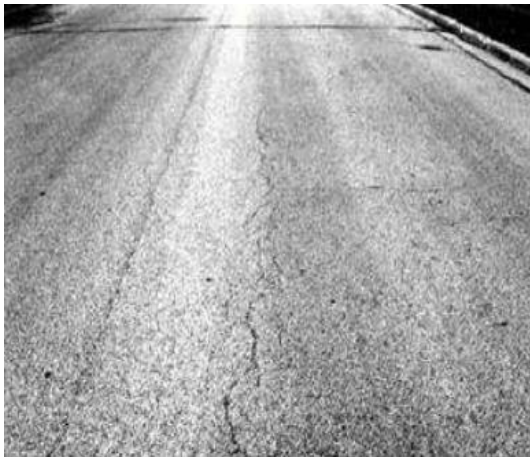
Figura 2 Grado de gravedad (L) - Piel de cocodrilo.
