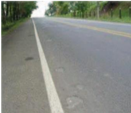
Figura 95 Nivel de gravedad (1) - Descascaramientos.
