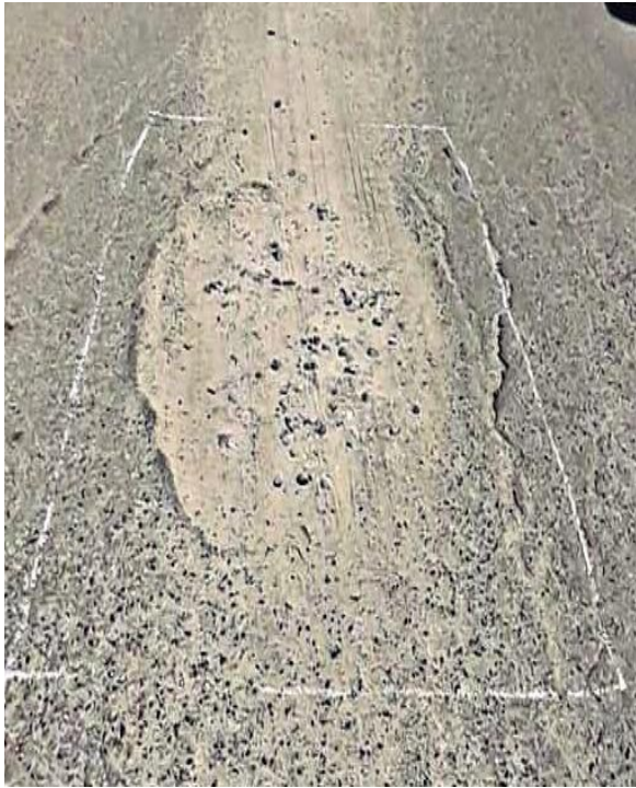
Fotografía 15 Identificación de tipo de falla hueco, nivel de severidad alto.
