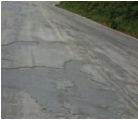
Figura 97 Nivel de gravedad (3) - Descascaramientos.
