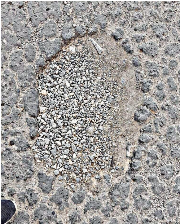
Fotografía 14 Identificación de tipo de falla hueco, nivel de severidad alto.
