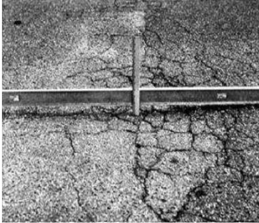
Figura 19 Grado de gravedad (H) – Depresión.
