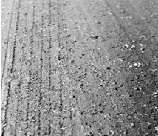
Figura 7 Grado de gravedad (H) - Exudación.
