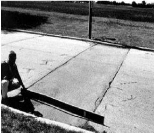
Figura 33 Grado de gravedad (M) - Parcheo.
