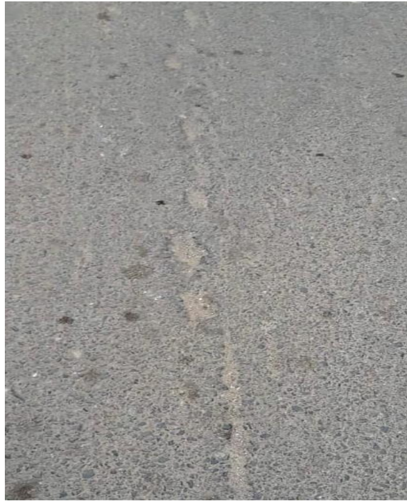
Fotografía 19 Identificación de tipo de falla grietas longitudinales y transversales, nivel de severidad medio.
