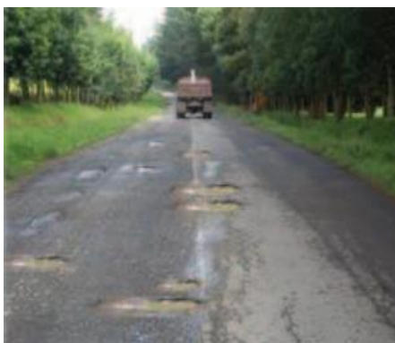
Figura 85 Nivel de gravedad (3) - Ojos de pescado.
