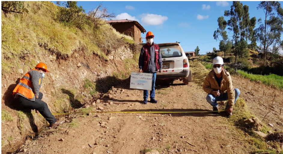
Figura 2. Cunetas de la vía
