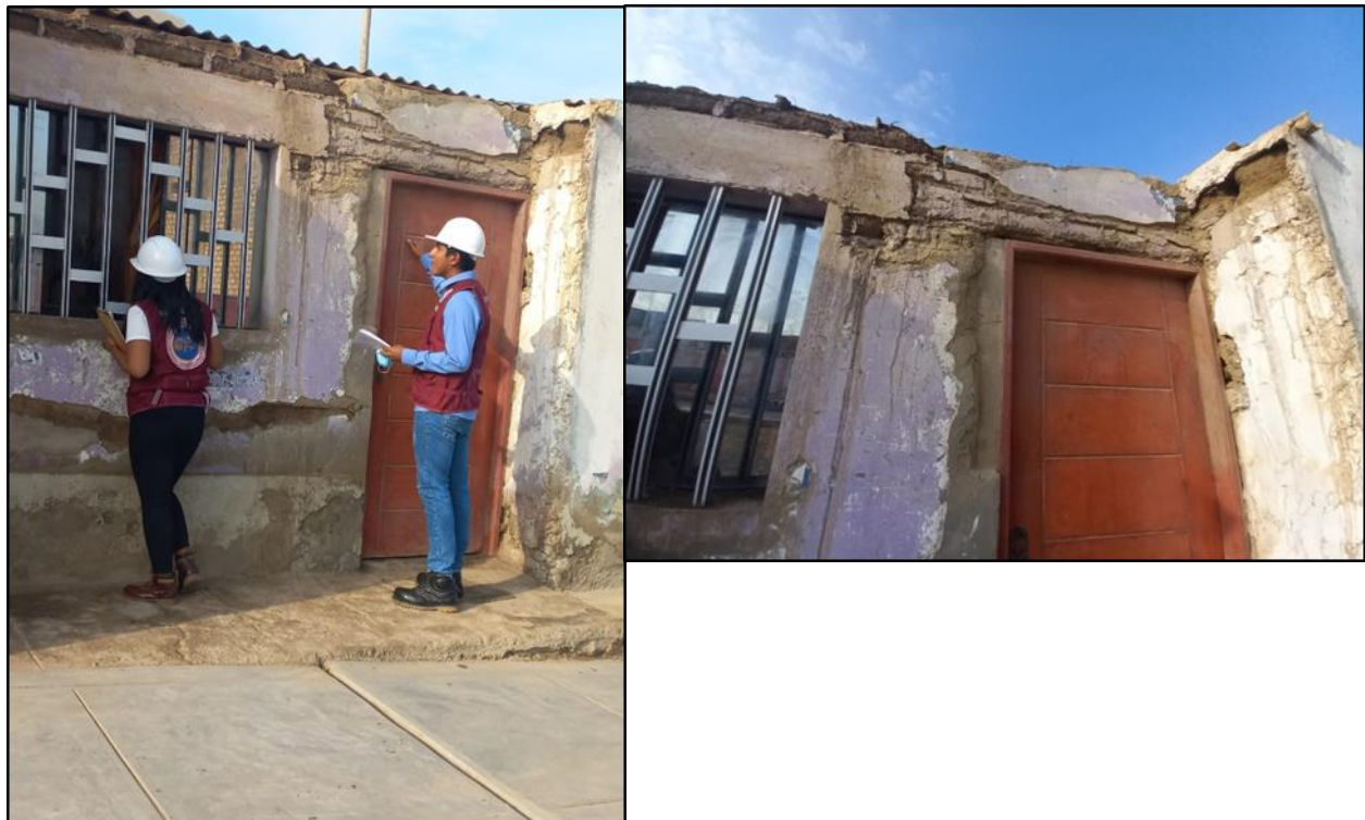
Figura 24 Observación en otra vivienda
