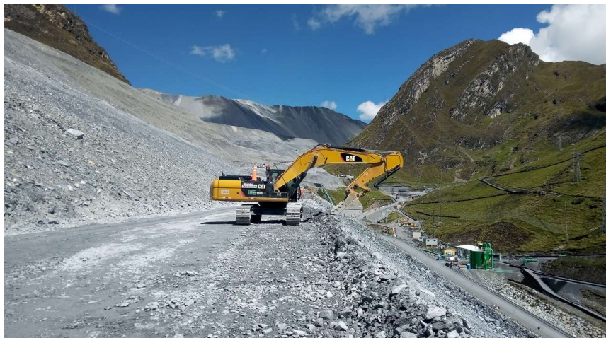
Figura 24. Perfilado y conformación de muro de seguridad.
