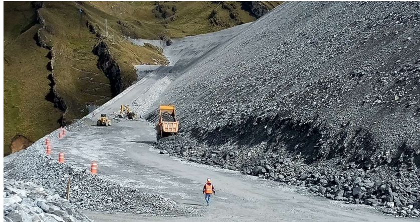
Figura 22. Descarga de material 3B en plataforma de relleno.
