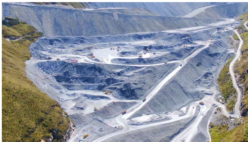
Figura 14. Cantera de extracción de material enrocado 3B.
