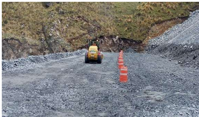
Figura 26. Compactación de plataforma 3B.
