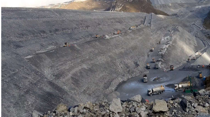
Fotografía 1. Trabajos en el espaldón de presa de relave.
