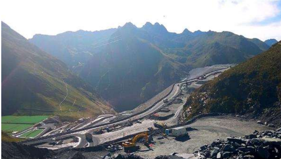
Figura 16. Ruta de acarreo de la cantera Tucush hacia el espaldón de PDR.
