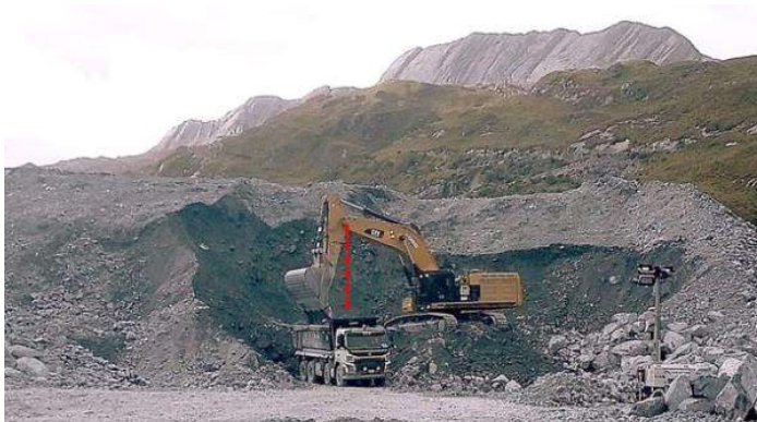
Figura 32. Distancia entre el volquete y excavadora.
