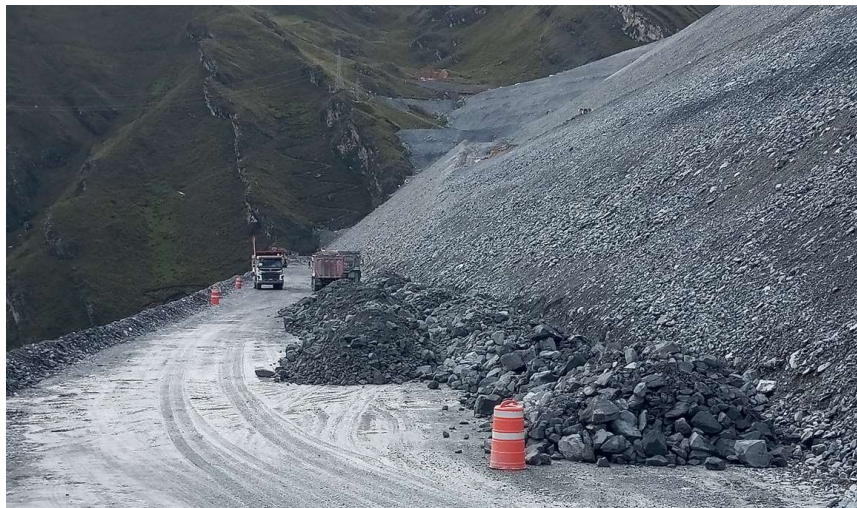
Figura 17. Zona de descarga en el espaldón de PDR.
