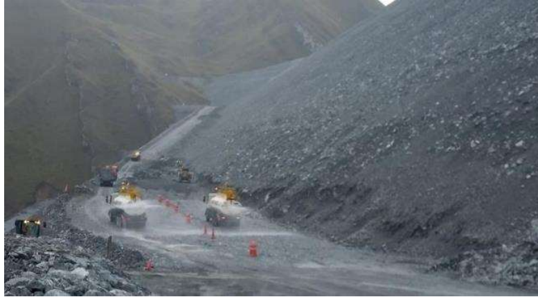
Figura 25. Riego de plataforma de relleno 3B.
