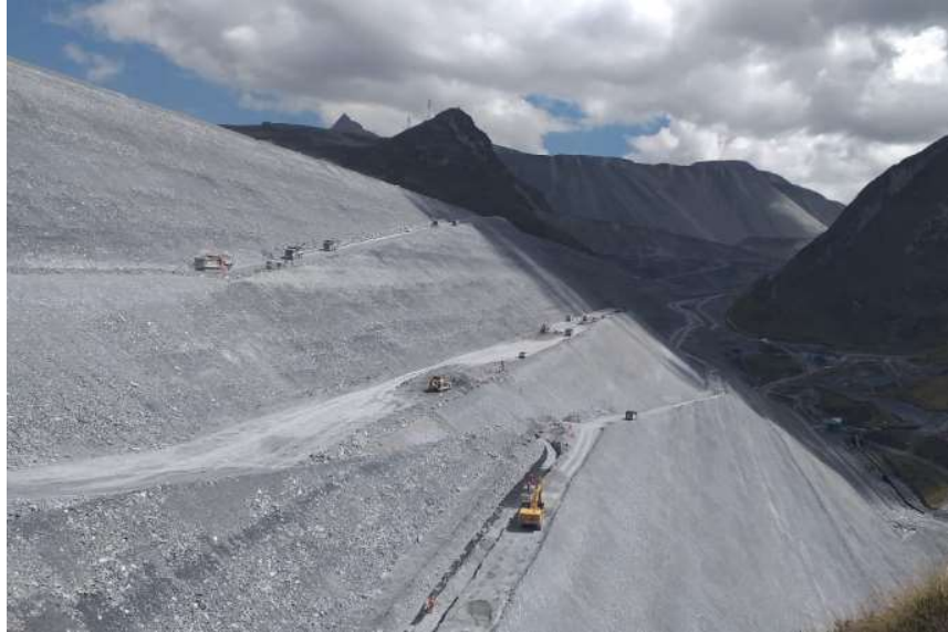
Figura 18. Trabajos en el espaldón de PDR.
