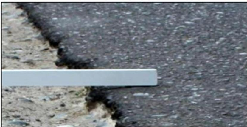
Nota: Se muestra el desnivel existente entre la berma y el carril de la pista
