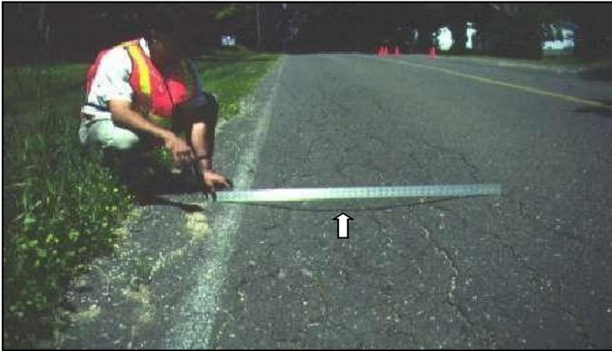
Nota: El nivel del pavimento, es menor al nivel del tramo de la pista. Se observa un asentamiento considerable en la vía.
