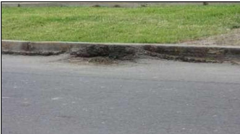
Nota: La vía del pavimento sufre daños de levantamiento, deformando el perfil de la vía.
