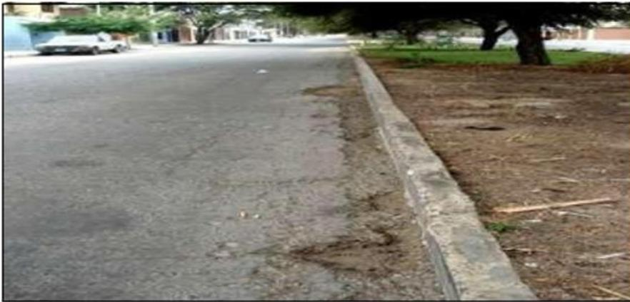
Nota: Se aprecia que la grieta de borde ha dañado severamente el borde de la via
