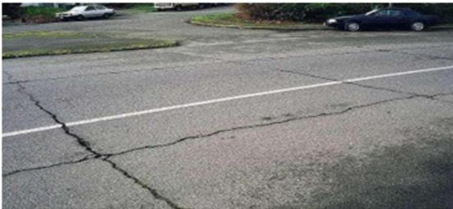
Nota: Grieta de reflexión de juntas de losa de concreto: se observa una fisura transversal que atraviesa todo el ancho del carril
