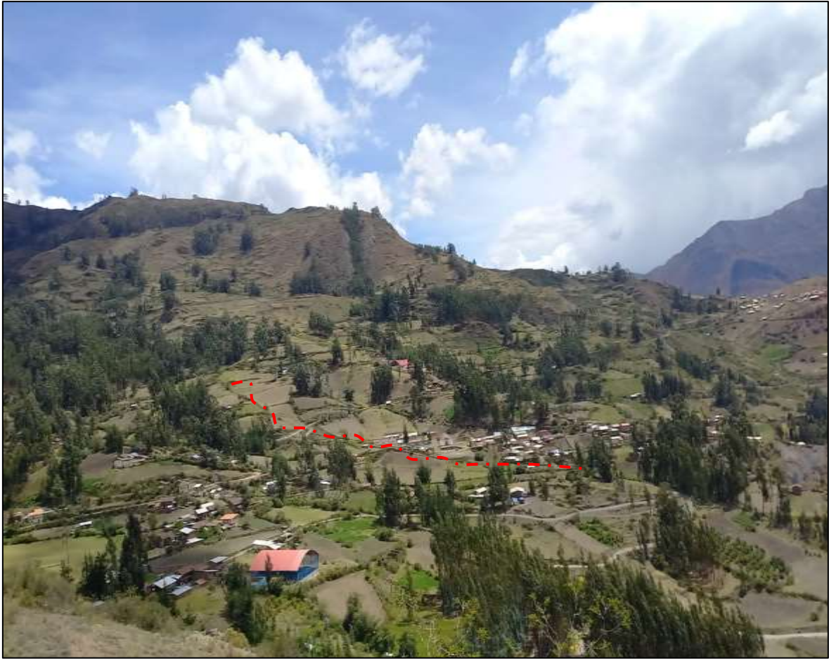
Figura 21. Escarpe lateral en el cuerpo del deslizamiento 1 (DES 1).
