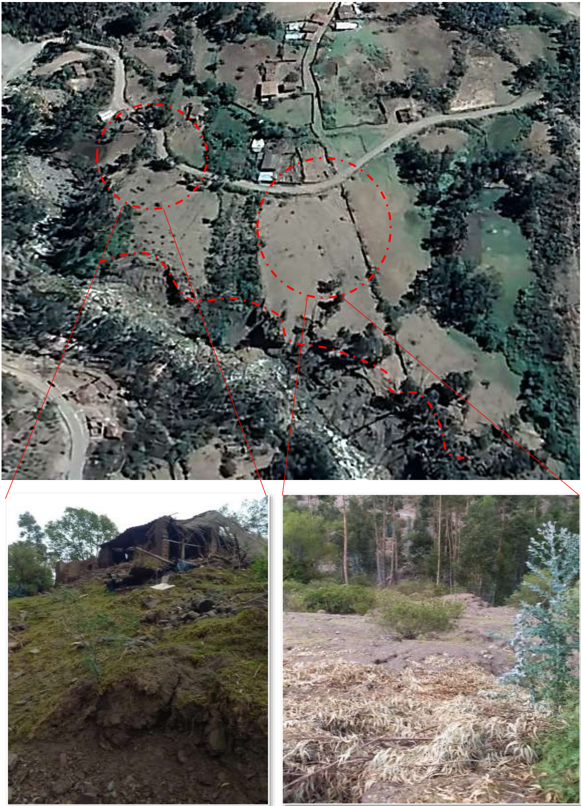
Figura 20. Vista panorámica del socavamiento lateral del río Rurichinchay en la ladera del depósito coluvial, sí mismo se pueden las grietas tensionales generadas en las zonas aledañas como también los daños a las viviendas cerca al lugar.
