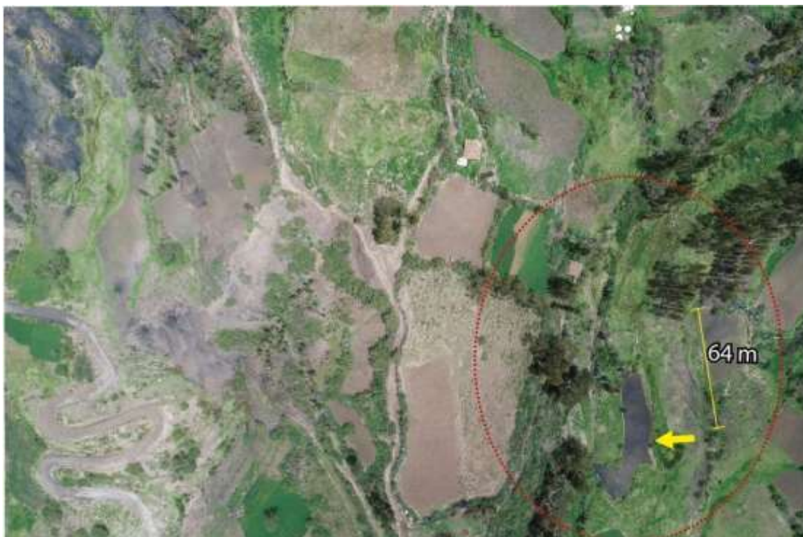
Figura 24. Vista panorámica de las grietas tensionales en el cuerpo del deslizamiento 3 (DES-3)
