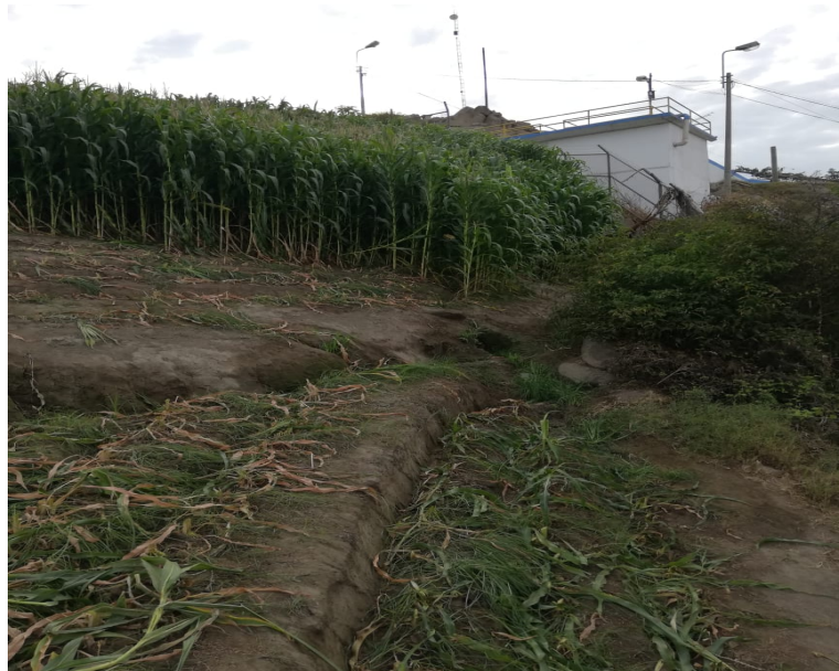
FOTO N°14: CONTINUACION DEL RECORRIDO DE LA LINEA DE CONDUCCION HACIA EL RESERVORIO, NOTECE VISTA PANORAMICA DEL C.P SAN MIGUEL
