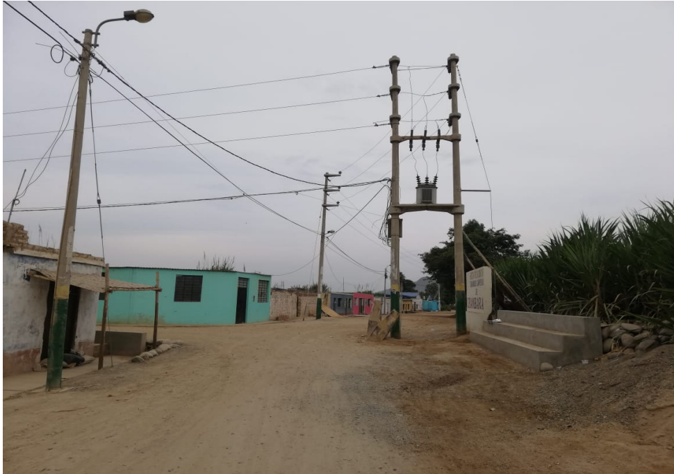
FOTO 03: VISTA CONTINUACION DEL C.P CHAMBARA BAJA
