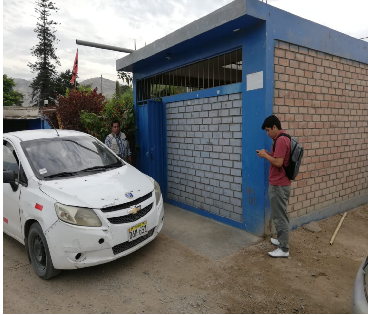
FOTO N°9: VISTA DE LA CESETA DE BOMBEO DONDE SE UBICA EL POSO TUBULAR, C.P SAN MIGUEL
