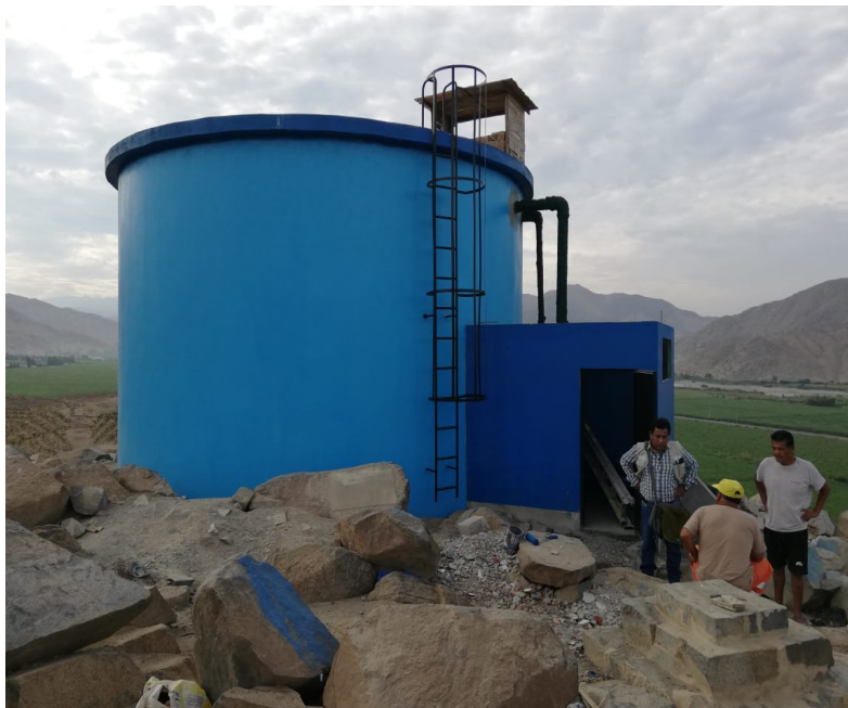
FOTO N°15: VISTA PANORAMICA DEL RESERVORIO CAPASIDAD 160 m3, EN COMPAÑÍA CON EL PERSONAL DE LA JASS CHAMBARA
