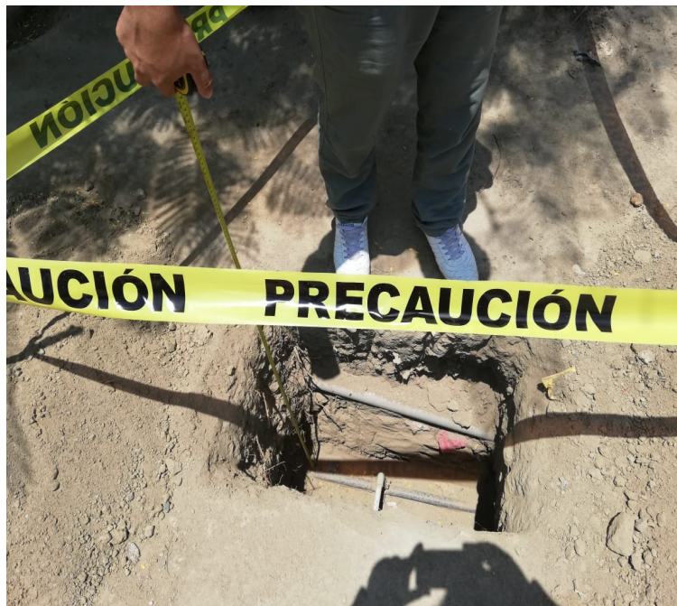
FOTO N°18: EXCAVACION DE EXPLORACION PARA VERIFICAR LA TUBERIA DE DISTRIBUCION QUE PASA EN EL C.P DE CHAMBARABAJA TUBERIA DE 2" LIVIANO
