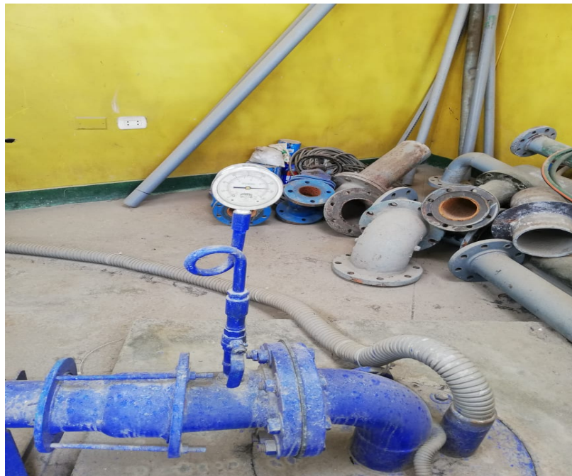
FOTO N°10: UBICACIÓN DEL POSO TUBULAR EN EL C.P SAN MIGUEL, NOTECE LA TUBERIA DE SUCCION CON SUS ACCESORIOS.
