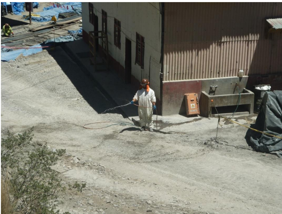
Figura 36. Control de material particulado (polvo).
