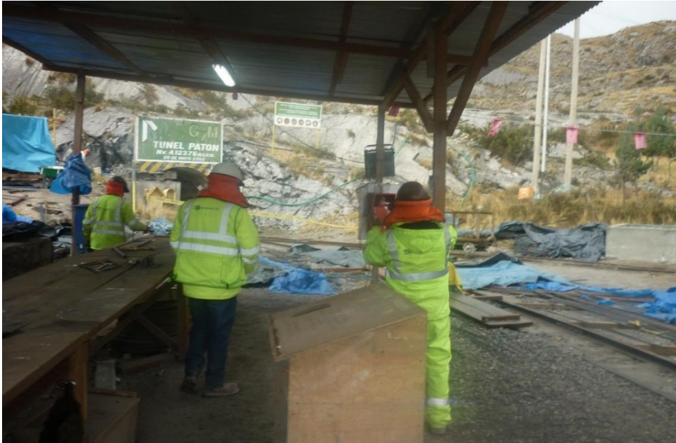
Figura 51. Supervisión del Gerente del proyecto, de que los materiales metálicos estén impermeabilizados (plástico), las precipitaciones pluviales (lluvias) al tener contacto con los fierros (están alojados en el suelo) generan un líquido que afecta el suelo natural.
