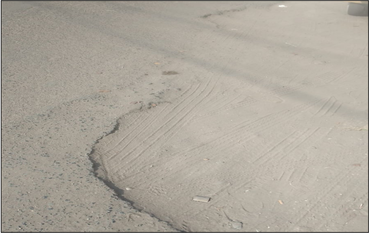
Nota: Identificación en proporciones del pavimento huecos.
