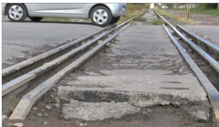
Figura 17. Cruce de Vía Férrea.
