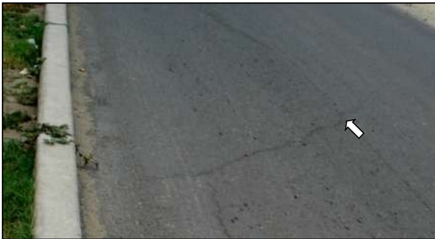
Figura 20. Fisuras Parabólicas.
