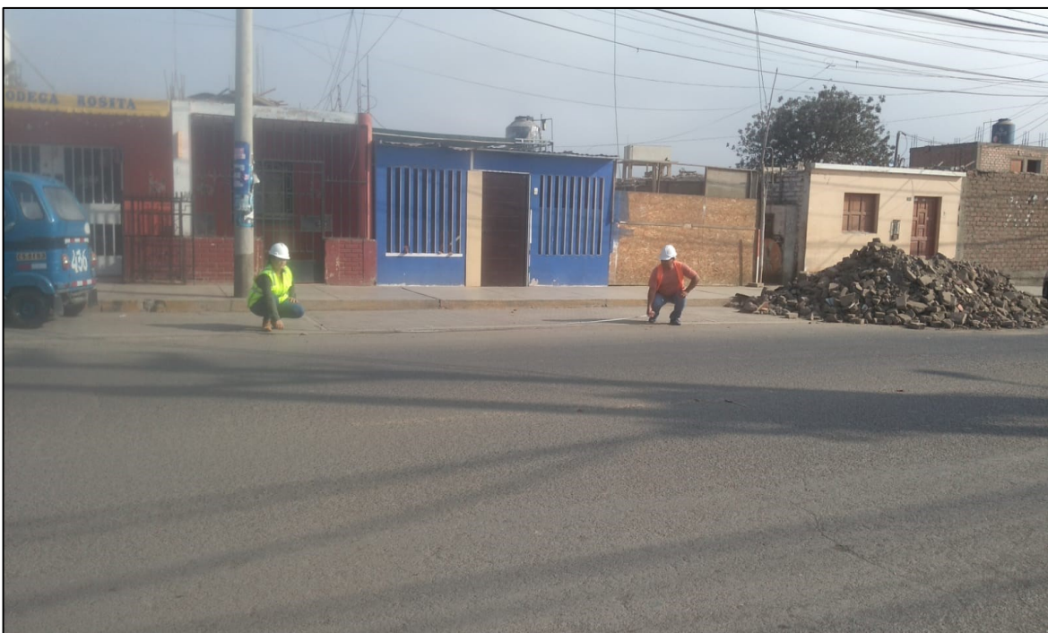
Nota: Cuantificación del largo del pavimento por unidad de prueba.
