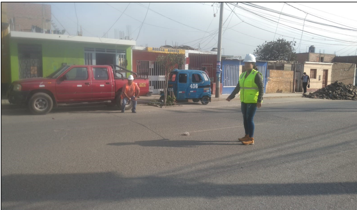
Nota: toma de medida del pavimento en su anchura.
