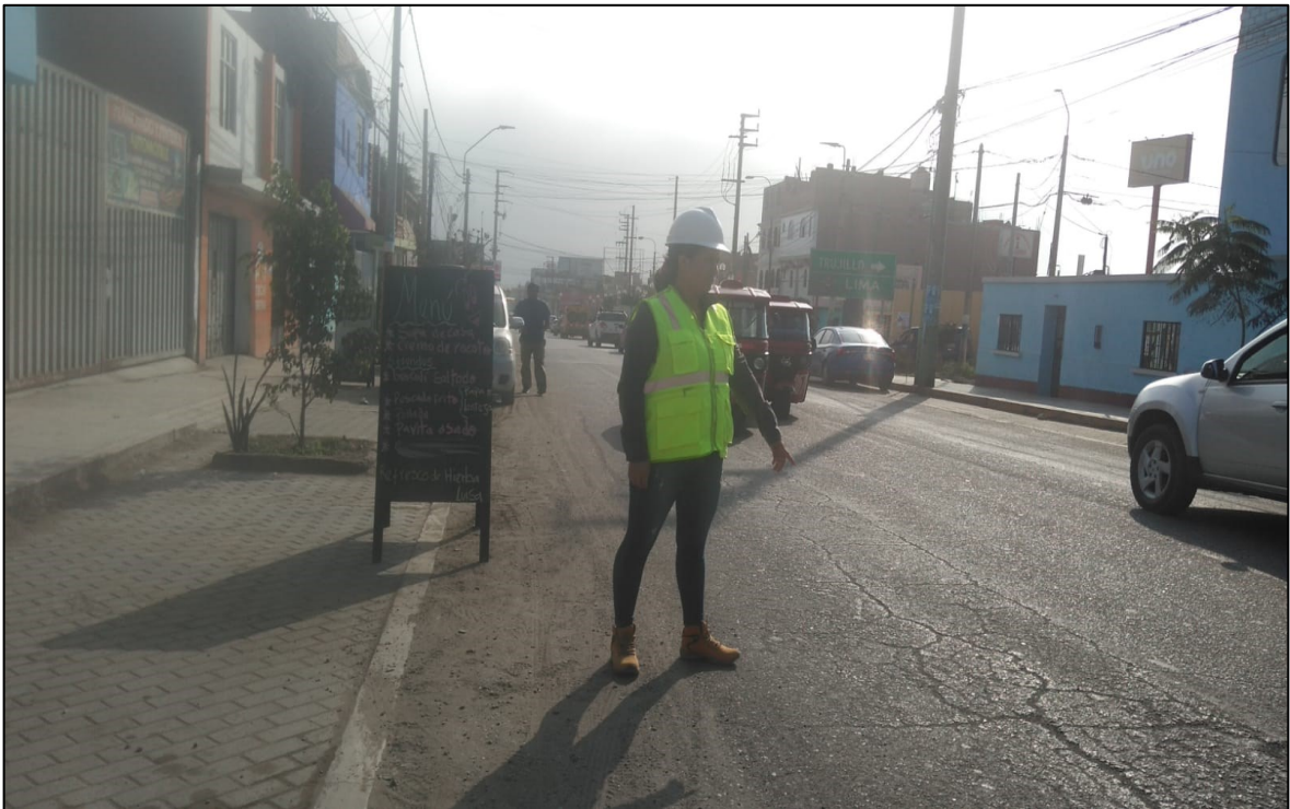
Nota: Identificación del agrietamiento por fatiga.
