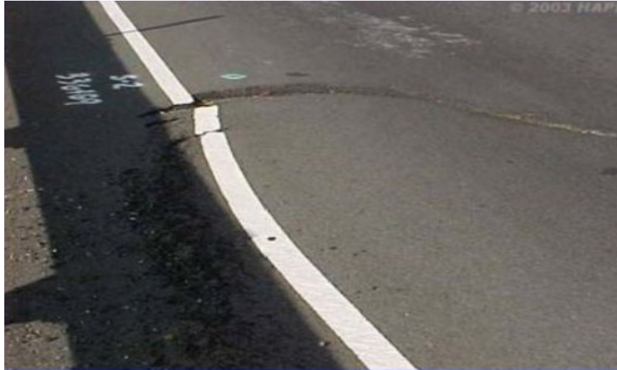
Figura 19. Desplazamiento.
