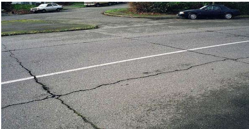
Figura 11. Fisura.
