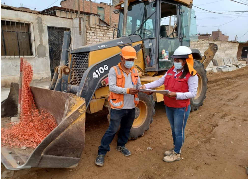
Figura 44. Encuesta al operador de la retroexcavadora (francisco huatorongo) en las afueras del almacén.
