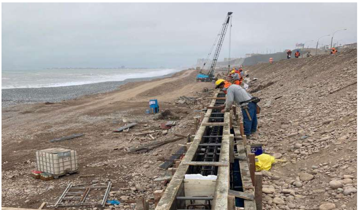
Vista de encofrado de viga cabezal de tablestacado.
