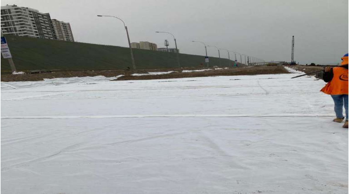
Vista de conformación de capas de vía.
