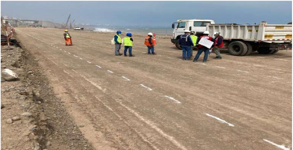
Vista de prueba de viga Benkelman.
