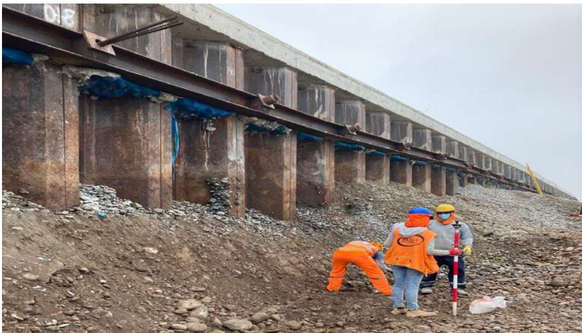
Vista de muro de tablaestacado.
