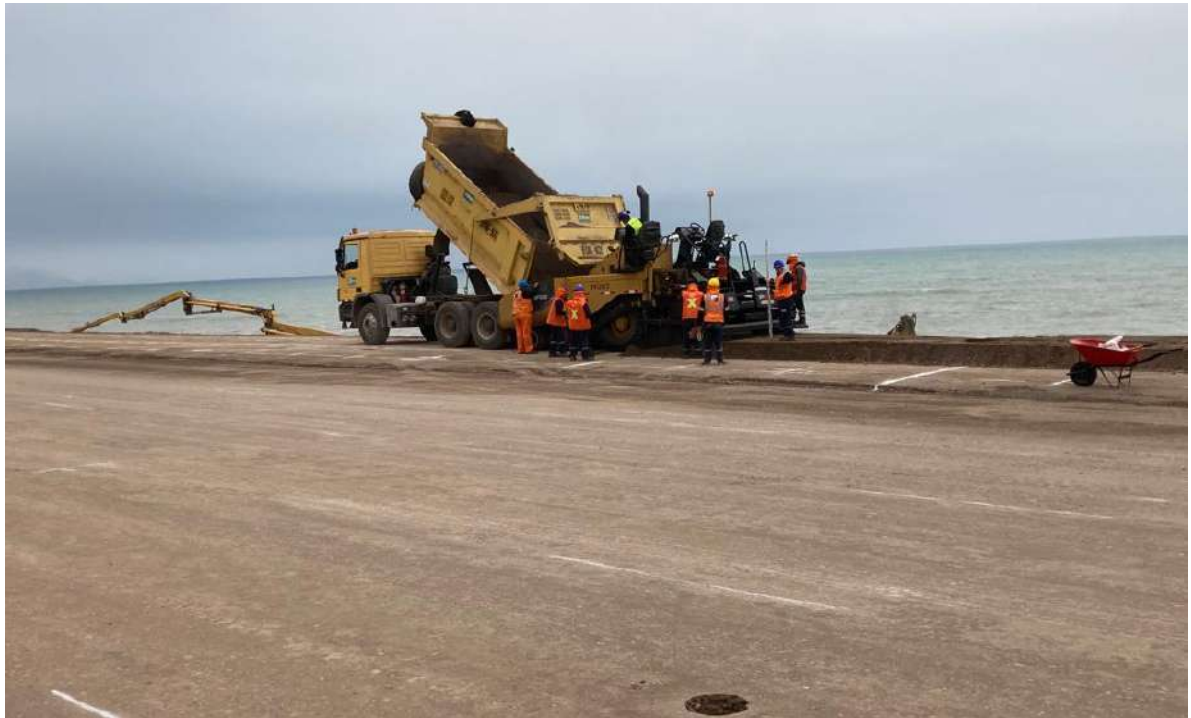
Vista de conformación de base de vereda.
