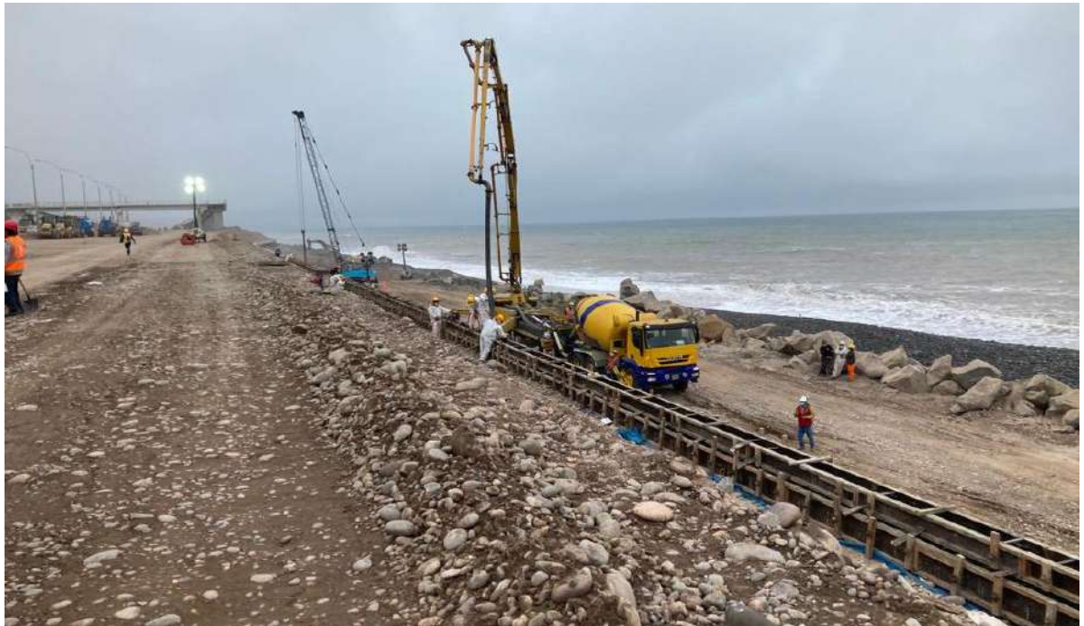
Vista de vaciado de viga cabezal.
