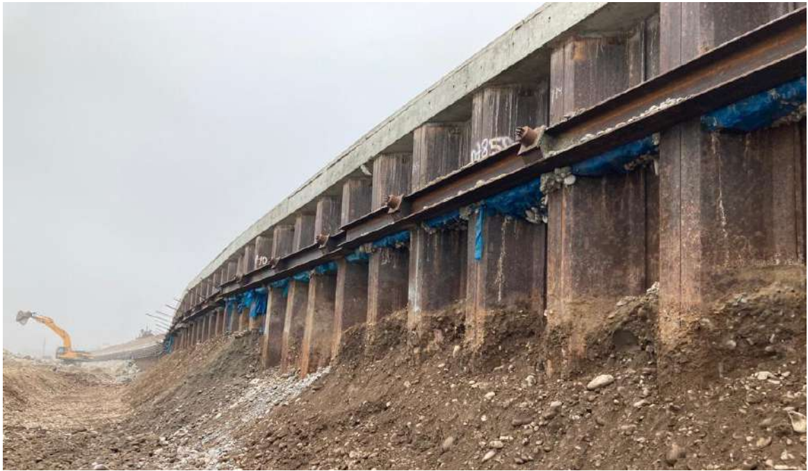
Vista de muro de tablaestacado.
