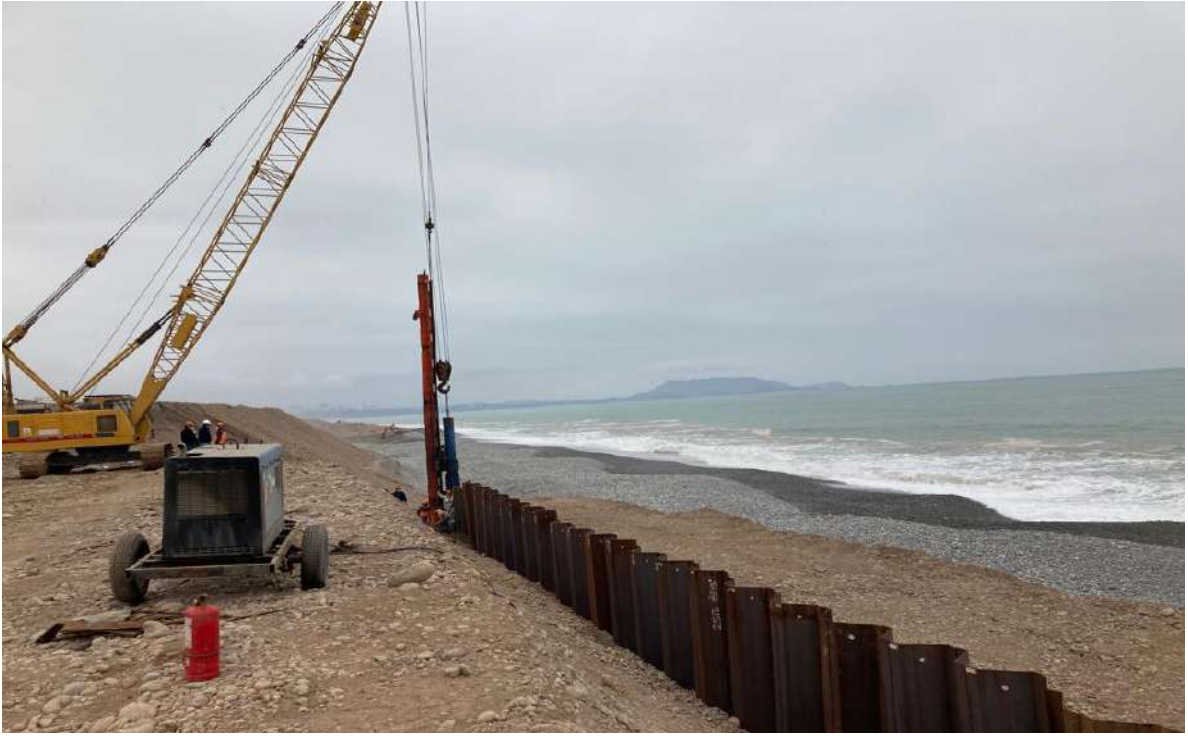
Vista de martillado de tablaestacado.
