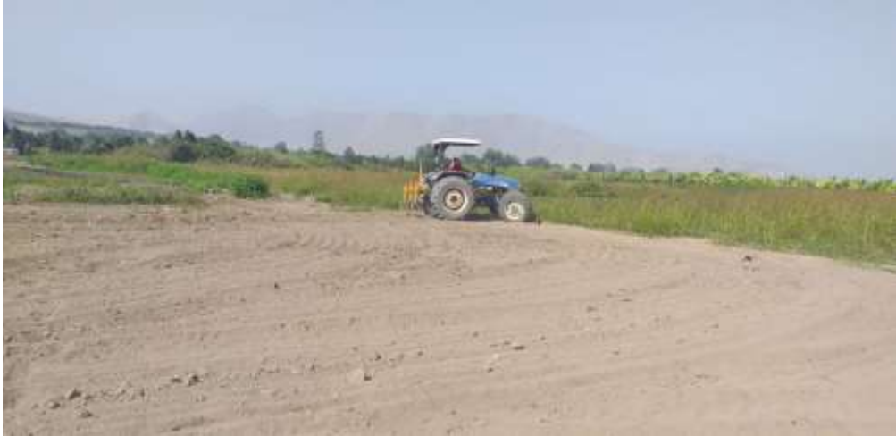
Figura 6. Preparación del terreno
