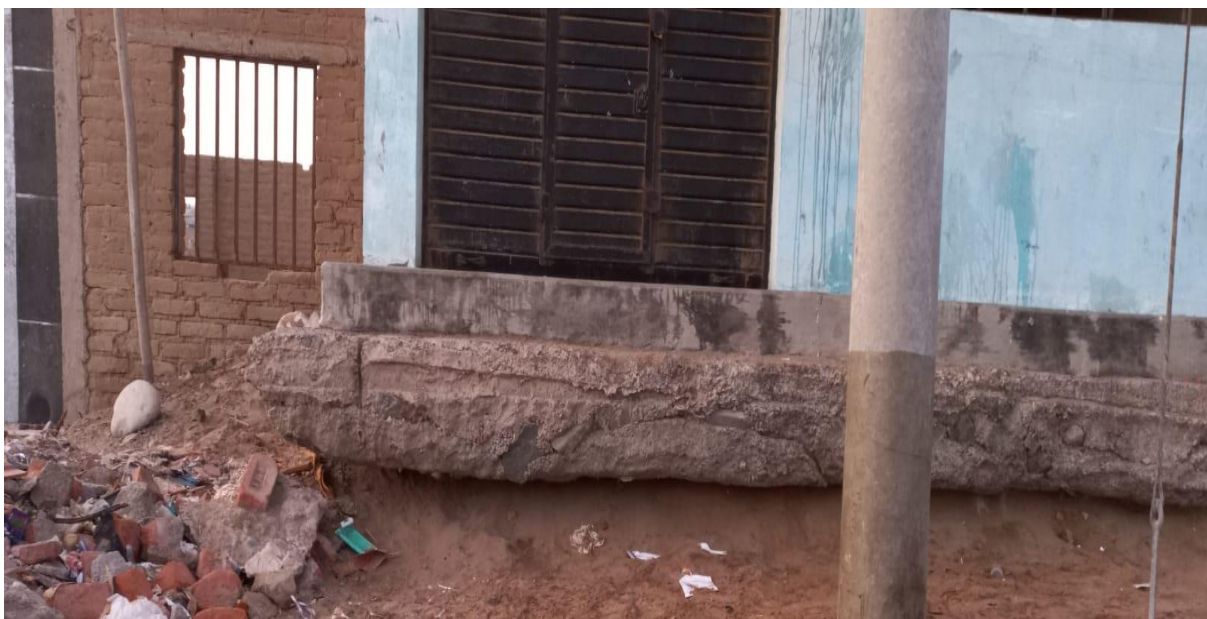
Figura 8. Cimentación asentada en vivienda n° 02 en calle sin número del sector Santa Cruz.
