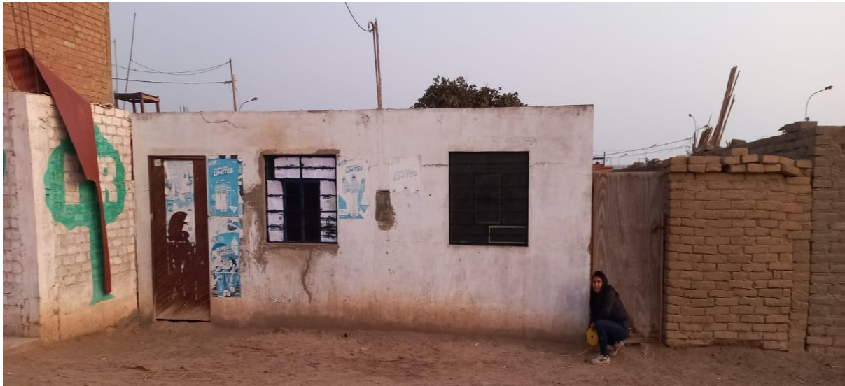
Figura 9. Medición de la vivienda n° 03 en calle principal del sector Santa Cruz.
