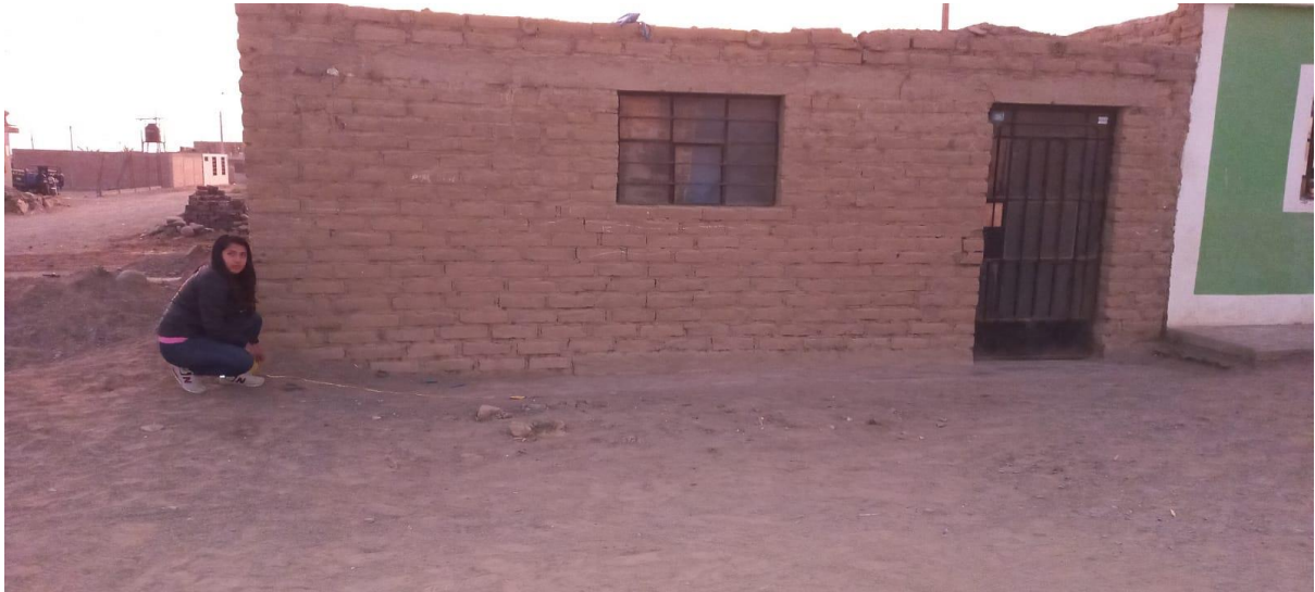
Figura 15. Medición de la vivienda n° 06 en calle transversal a la principal del sector Santa Cruz.
