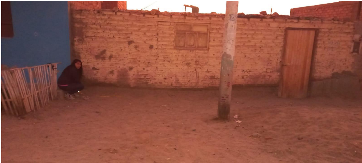
Figura 17. Medición de la vivienda n° 07 en calle transversal a la principal del sector Santa Cruz.
