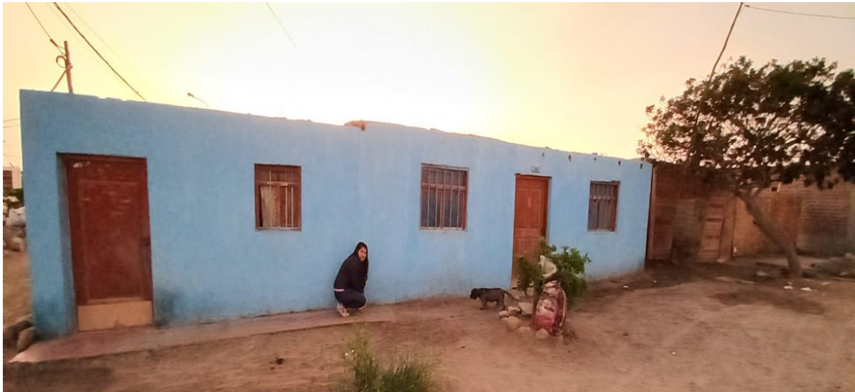
Figura 11. Medición de la vivienda n° 04 en calle principal del sector Santa Cruz.
