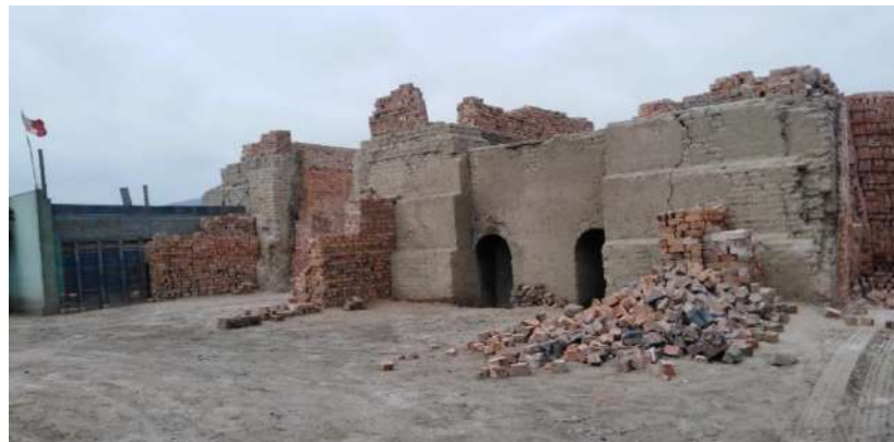
Figura 1. Ladrillera Cherlod ubicada en Supe
