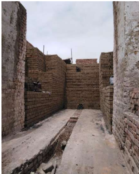
Figura 3. Horno de la ladrillera Kibi ubicada en Supe
