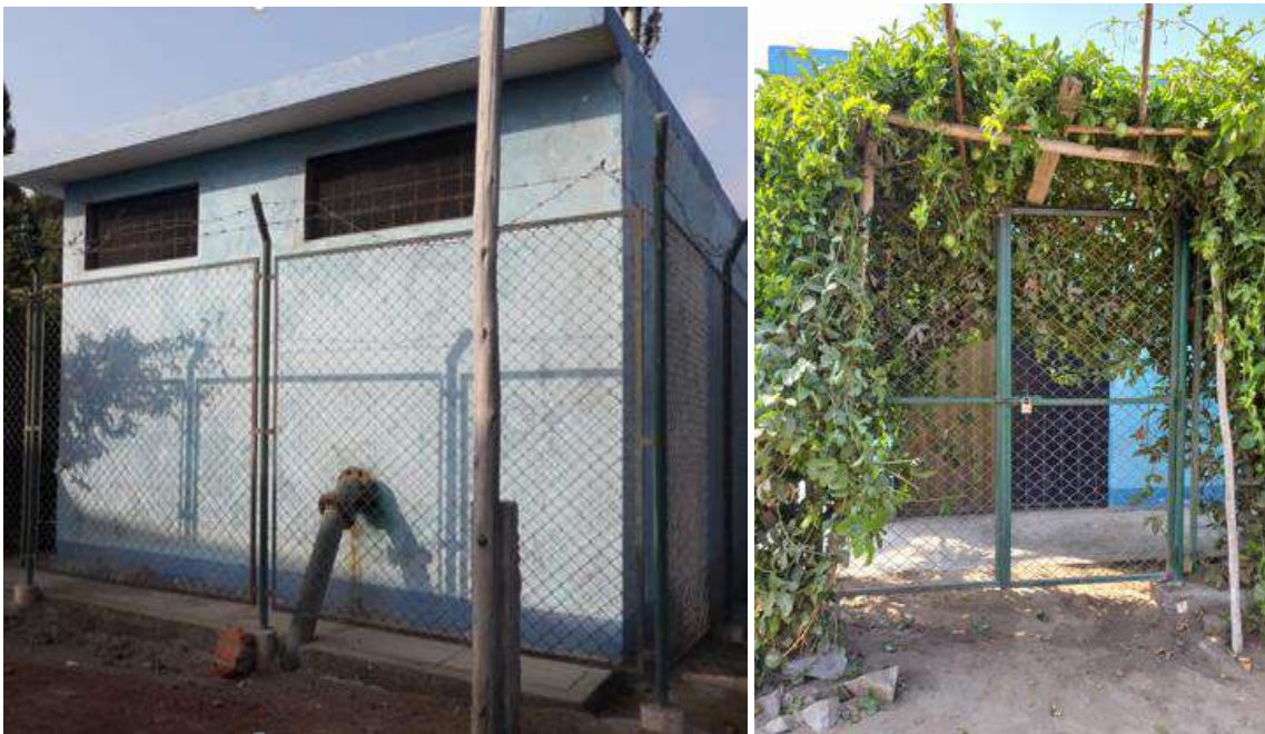
Figura 13. Vista lateral de la caseta de bombeo agua potable
