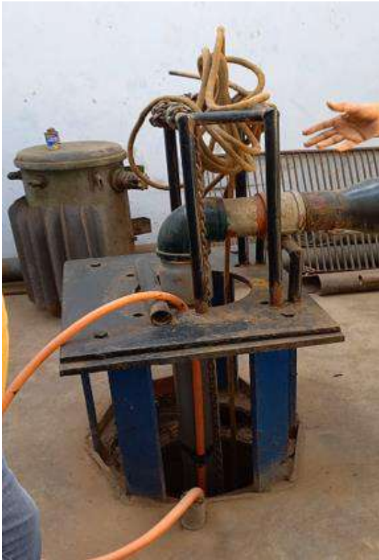
Figura 12. Captación de agua subterránea mediante una electrobomba sumergible
