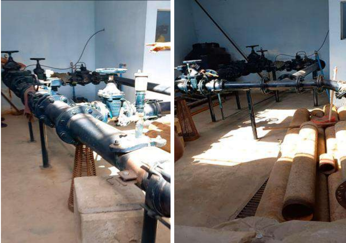
Figura 14. Vista interior de las instalaciones de la caseta de bombeo
