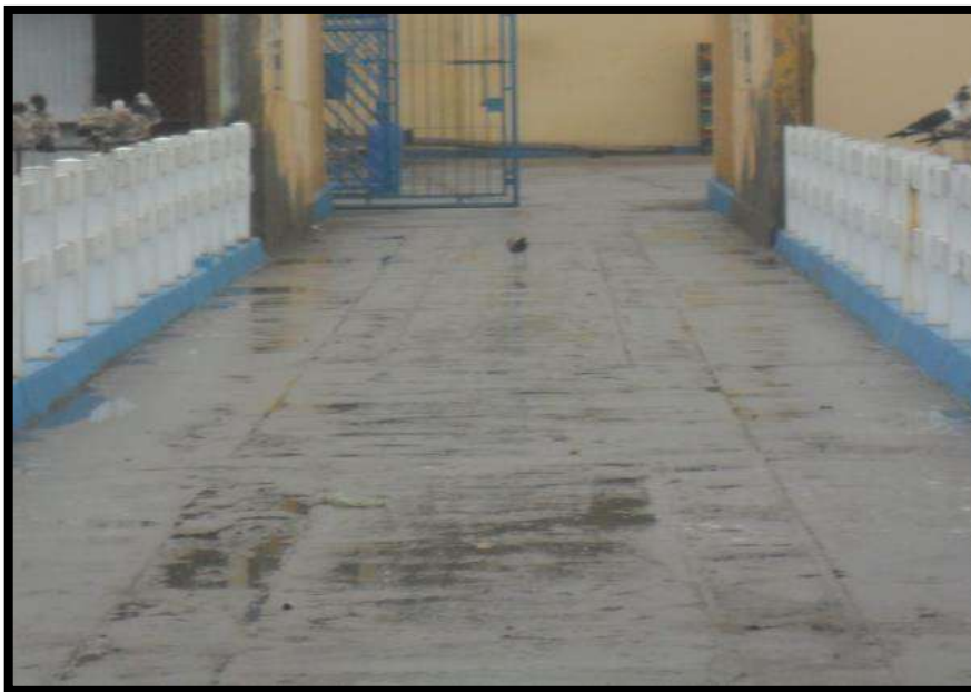
Figura 42: Limpieza de Pasadizos del Muelle del DPA
