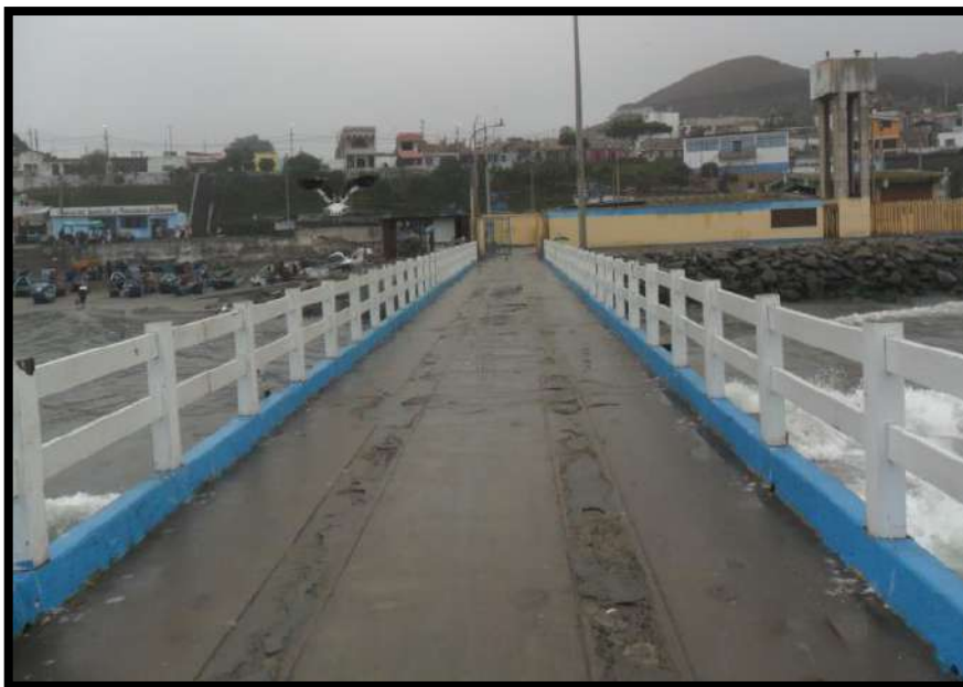
Figura 4: Piso del Muelle del DPA del Puerto de Chancay
