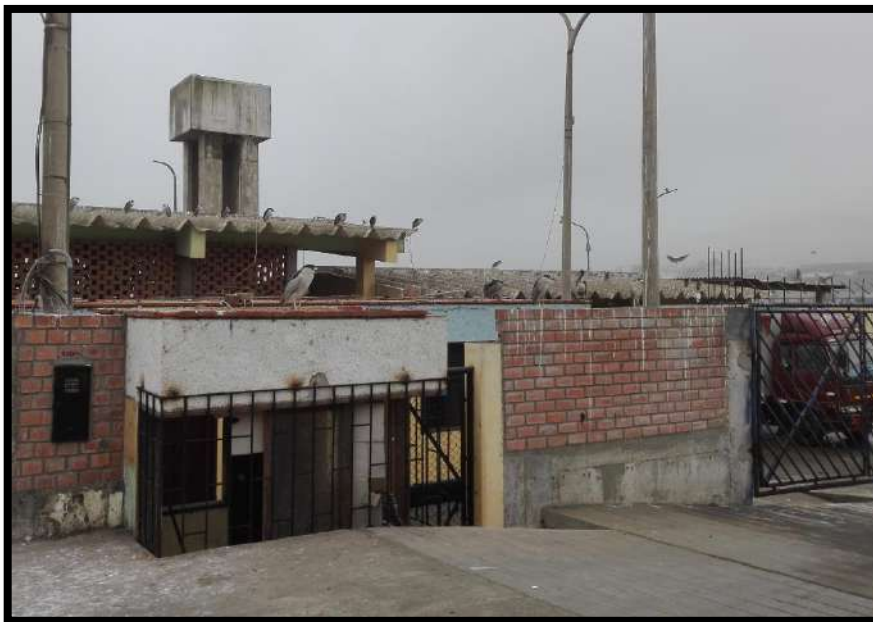
Figura 37: Presencia de Aves en los Techos y Alrededores del DPA
