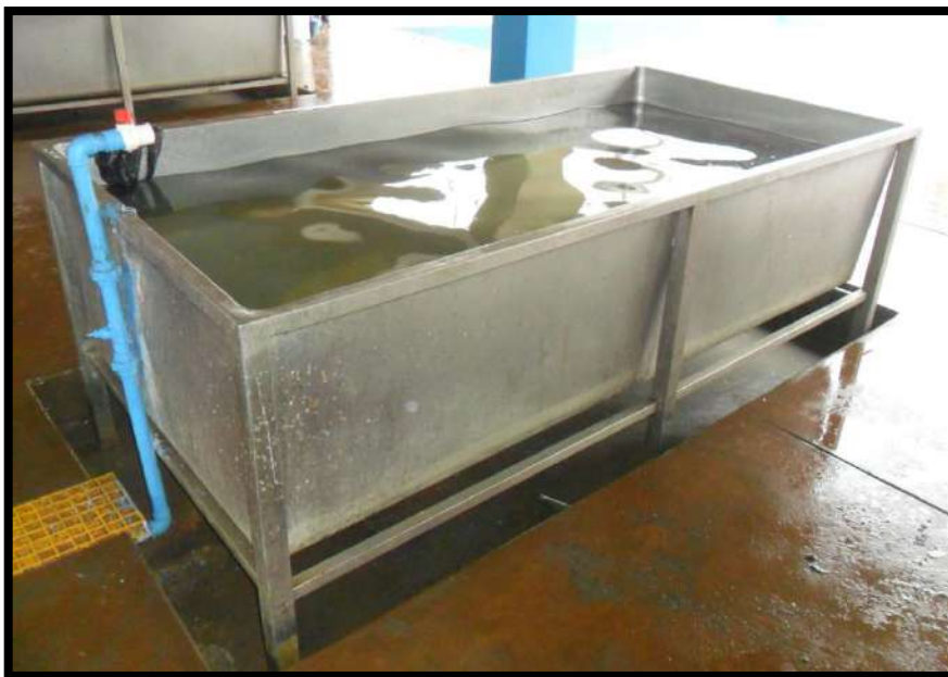
Figura 40: Tinas de Acero Inoxidable con Agua para Limpieza de Pisos
