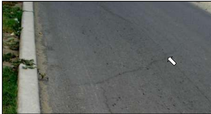
Figura 20 Grietas Parabólicas
