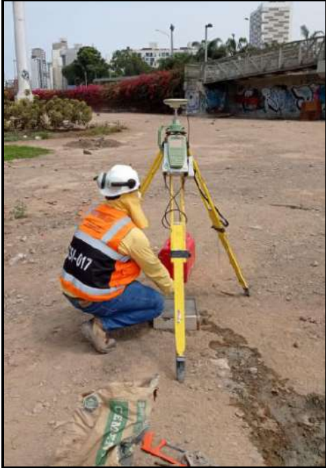
Figura 14: Lectura de altura de equipo. Fuente: Elaboración propia
