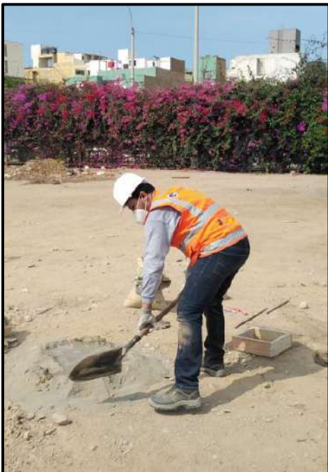
Figura 11: Construcción de monumentos. Fuente: Elaboración propia
