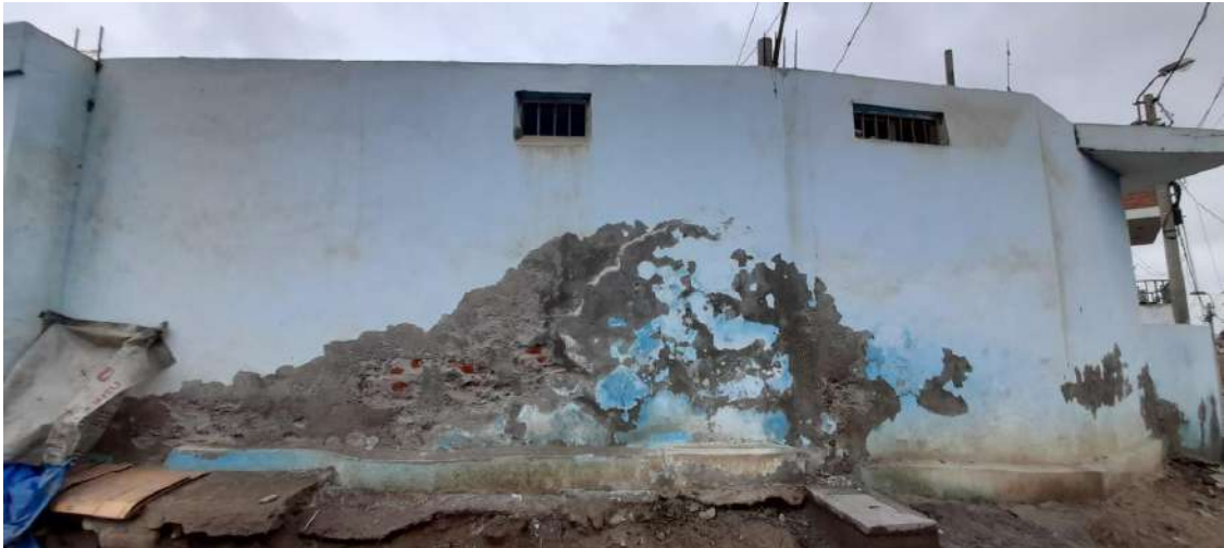
Figura 43. Presencia de confinamiento por elementos estructurales en la vivienda 11, en la mitad de la calle los Sauces.
