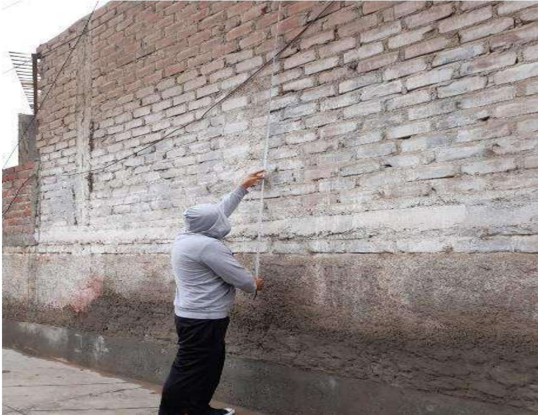
Figura 35. Ausencia de confinamiento horizontal (vigas) en la vivienda 09, zona media de calle los Laureles.
