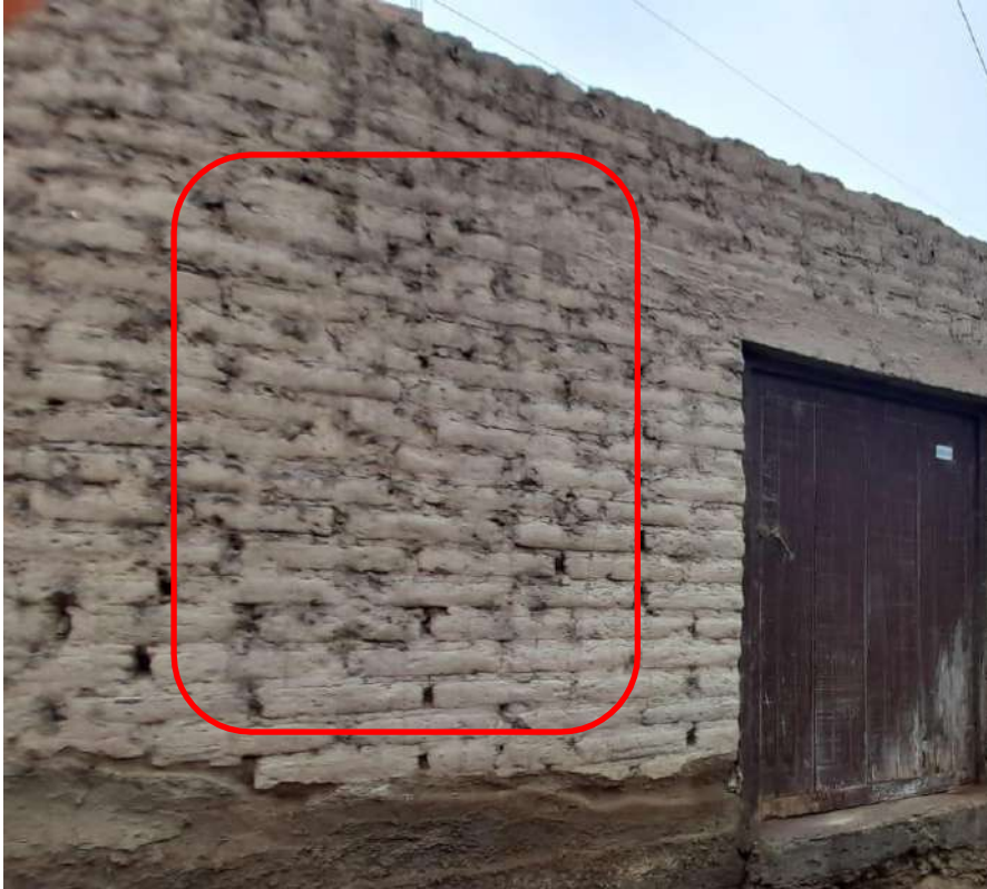
Figura 20. Falta de calidad de las unidades de mampostería requerida en la vivienda 05, entre la calle Indalecio Paz y los Sauces.
