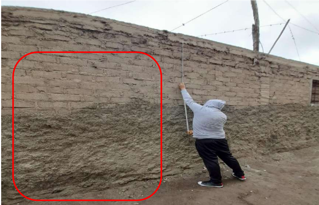
Figura 12. Falta de calidad de las unidades de mampostería requerida en la vivienda 03, en el pasaje Gamarra.
