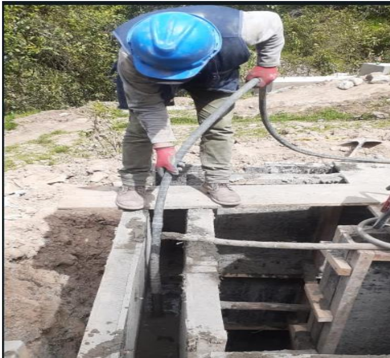
Figura 49: Vibrado del concreto en cimiento.
