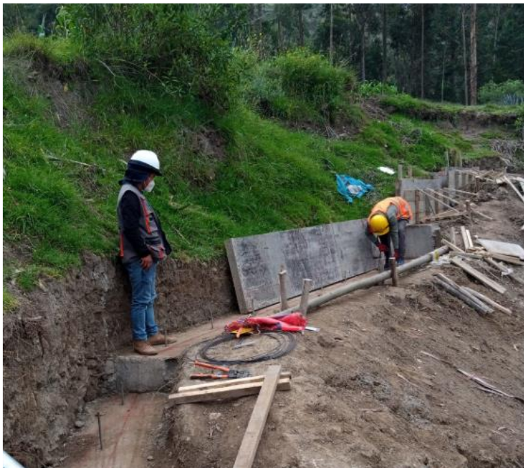
Figura 50: Verificación de trabajos para alineamiento de cimiento corrido.
