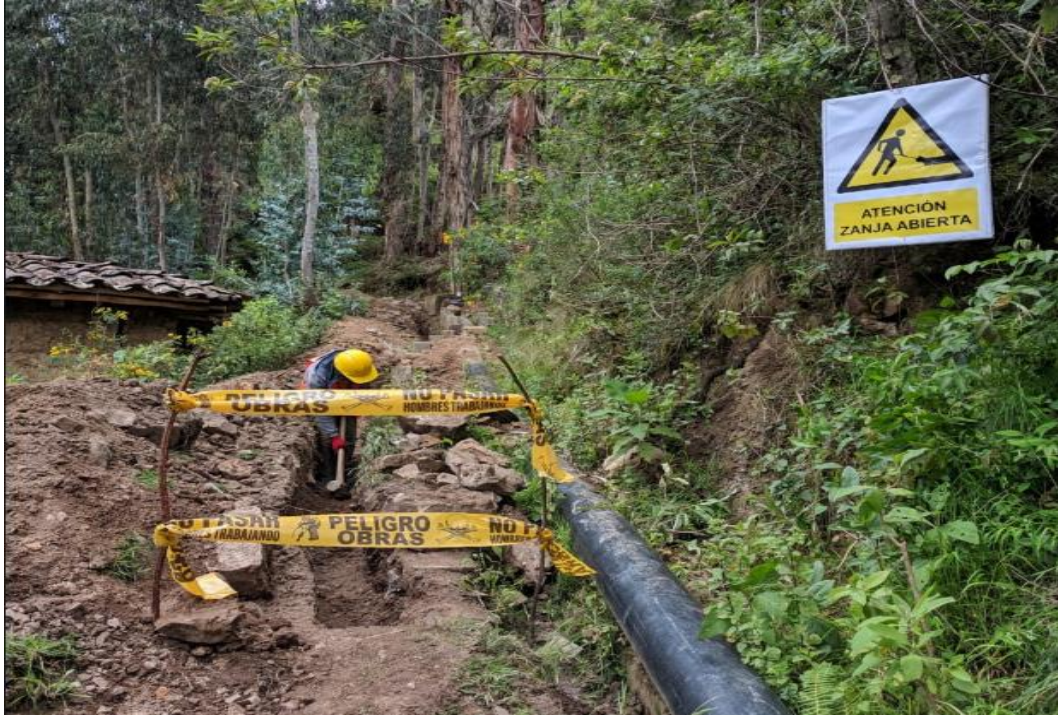
Figura 51: Verificación de seguridad en trabajos de corte.
