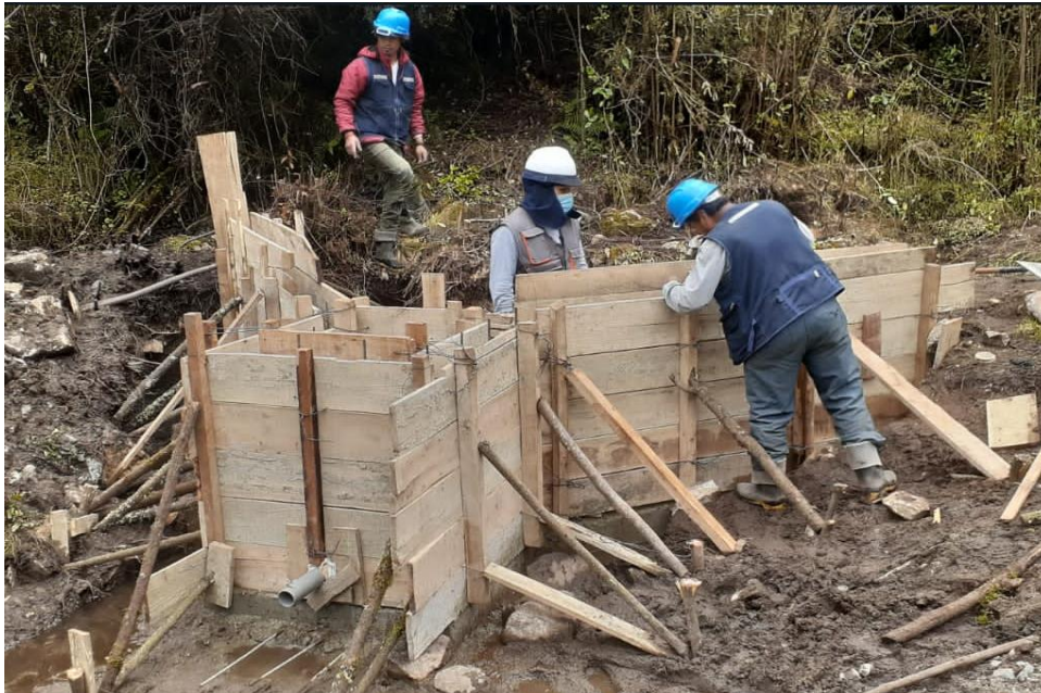
Figura 45: Verificación de trabajos por operarios.
