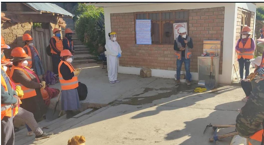
Figura 54: Charlas de seguridad en obra.
