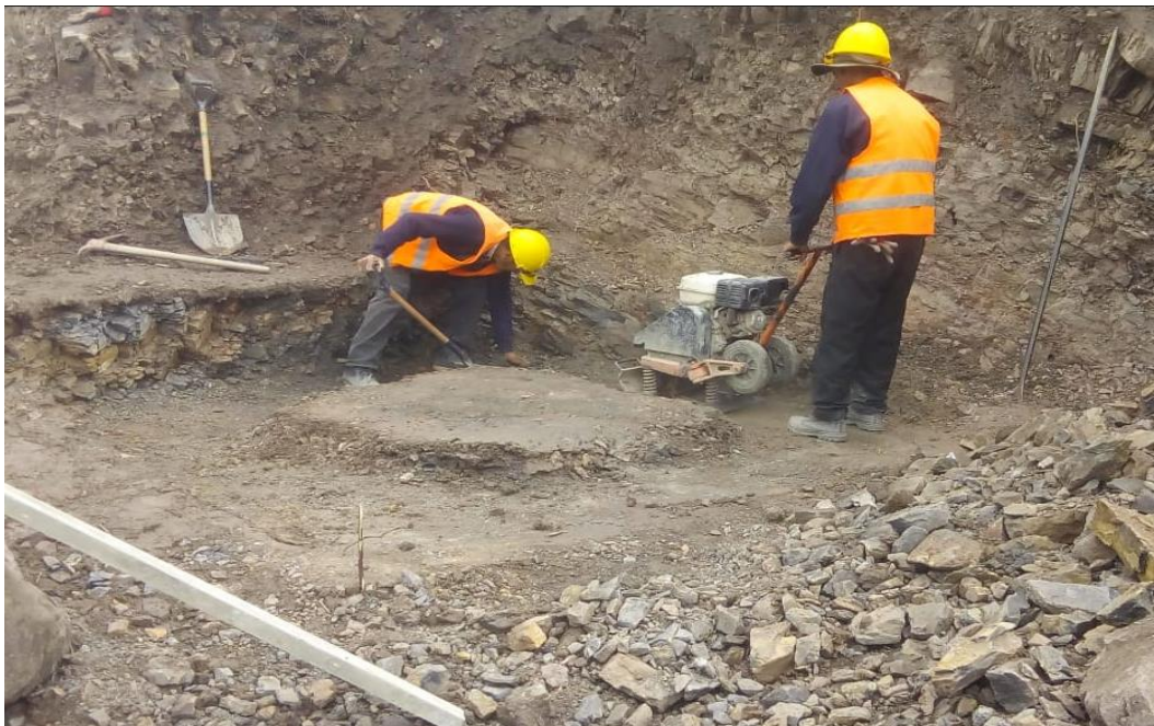
Figura 47: Trabajos de relleno y compactado.
