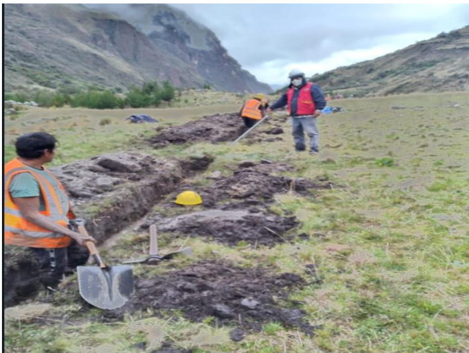
Figura 46: Verificación de trabajos de corte por participantes.
