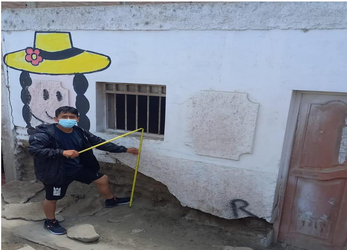
*Figura 15.* Medición de área dañada por salitre en vivienda 05.
