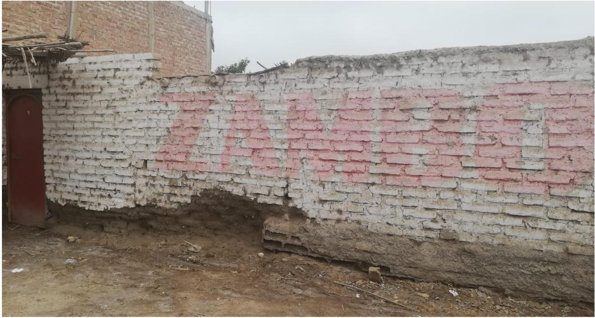
*Figura 10.* Vista frontal de muro sin columna en la vivienda 03.
