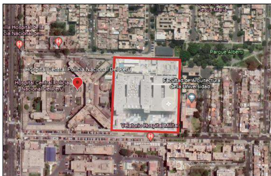
Figura 1. Obra Mejora de la Infraestructura del Servicio de Emergencia del Hospital Nacional PNP Luis N. Sáenz.
