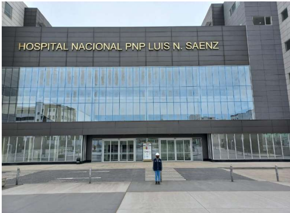
Figura 8. Obra Hospital Nacional PNP Luis N. Saenz.
