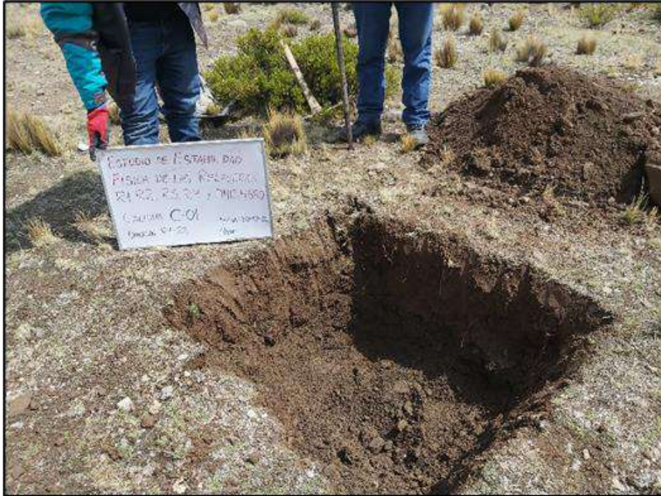
Inicio de excavación de la calicata C-01
