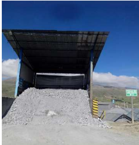
Figura 1. Tolva de grueso.
