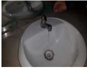
Fotografía N°5. Muestra que los caños del baño tienen fugas.
