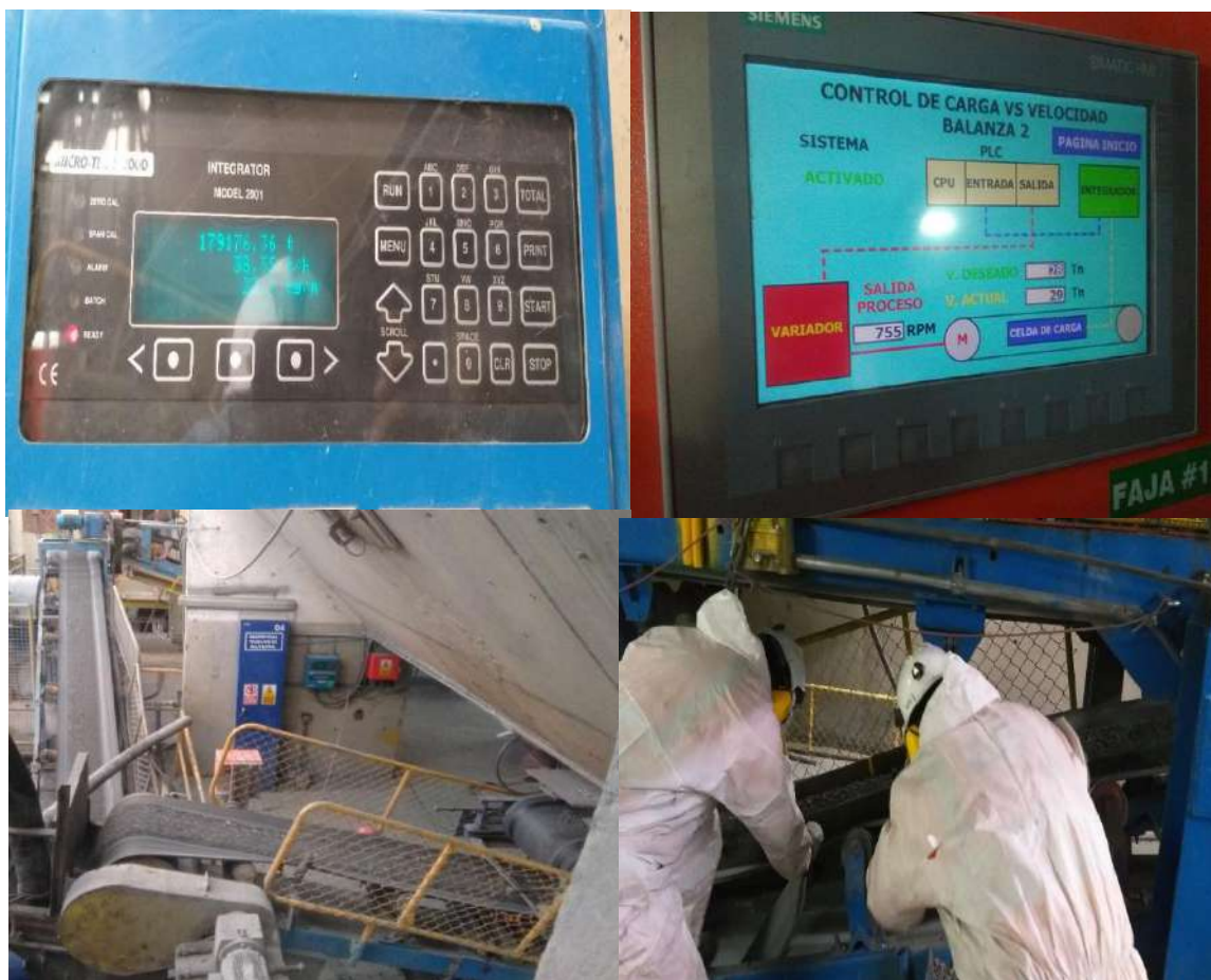
Figura 09. Faja transportadora en el área de la molienda
