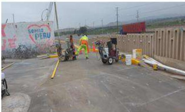
SE OBSERVA AL PERSONAL COLOCANDO LAS REGLAS METALICAS Y LAS TRAZADORAS PARA PINTAR LINEAS EN PAVIMENTO
