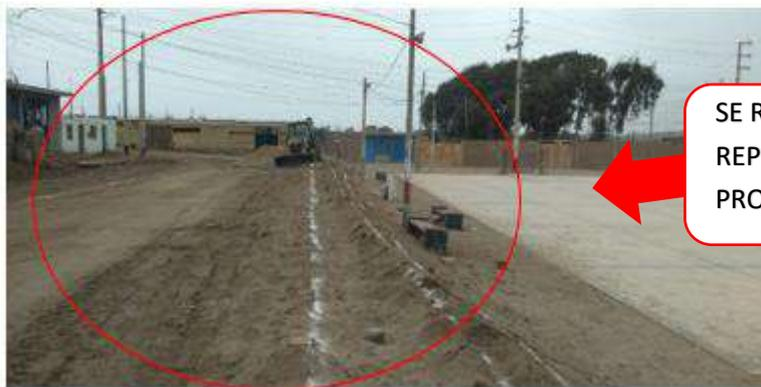
SE REALIZO TRAZO Y REPLANTEO DURANTE EL PROCESO DE PAVIMENTOS
