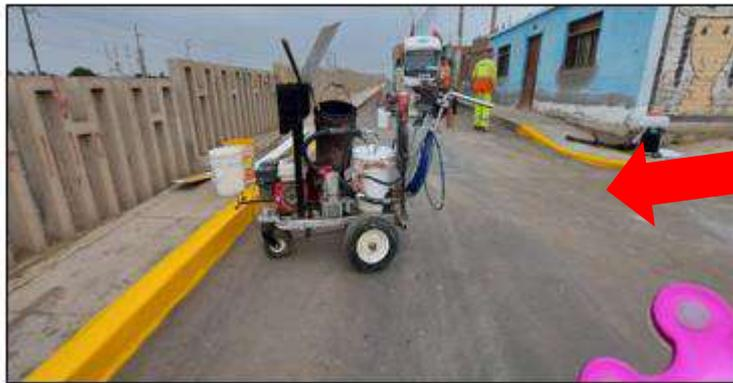
PINTURA EN VEREDAS, OBSERVAMOS AL PERSONAL EN EL COLOCADO DE LA PINTURA DEL CANTO DE VEREDAS CON LA AYUDA DEL TRAZADOR DE LINEAS Y PISTOLA PARA PINTAR.
