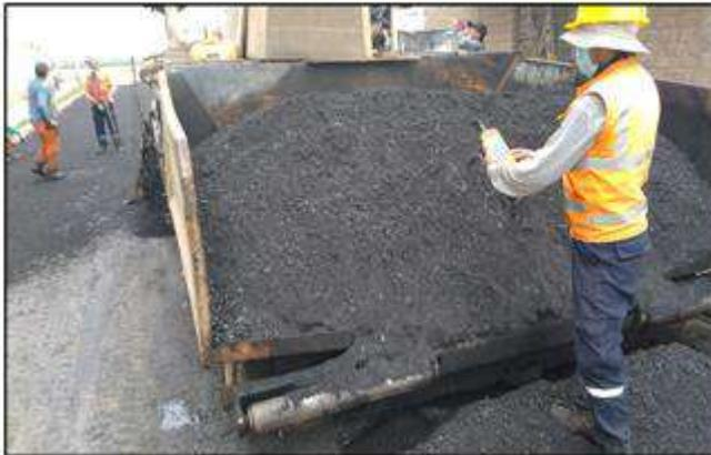
MEDICION DE TEMPERATURA DEL MATERIAL QUE SE USO EN EL ASFALTADO
