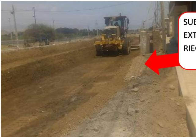
SUB BASE GRANULAR, EXTENDIDO, BATIDO, RIEGO Y COMPACTADO
