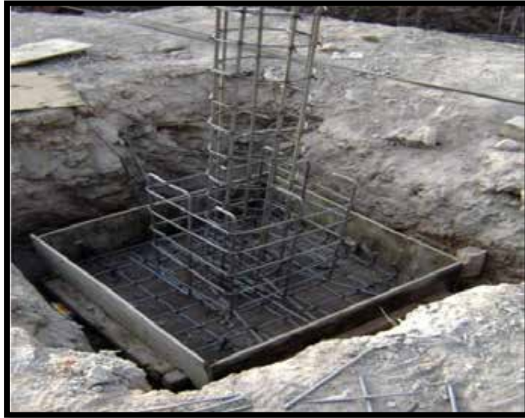
Figura 38. Construcción de una fundación directa o superficial.
