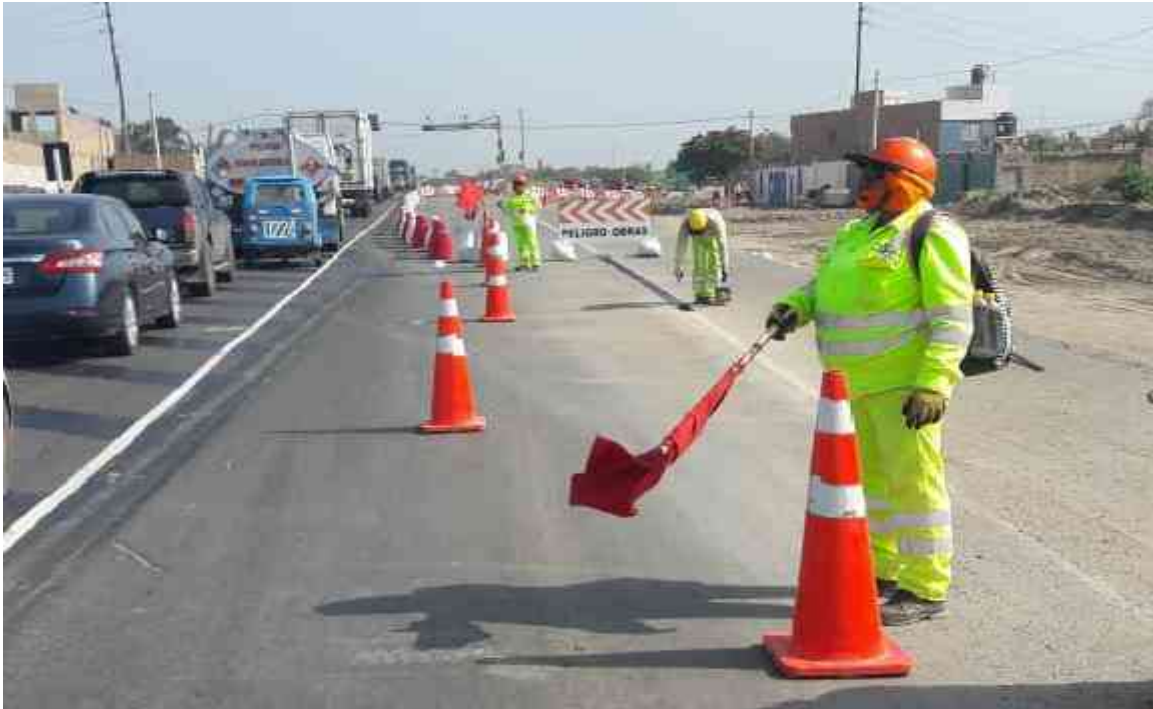
Figura 45. Cierre de vía para cortar la pista, con las vigías para evitar accidentes.
