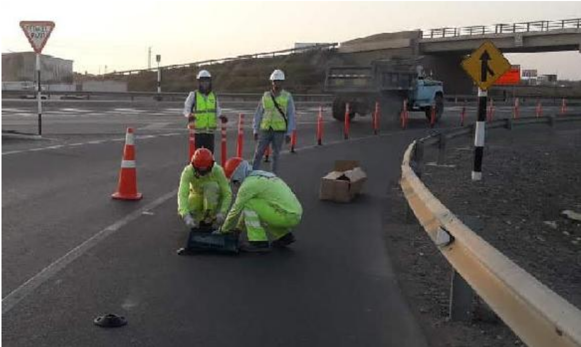
Figura 39. Colocación de vara de seguridad fijas, para evitar accidentes.
