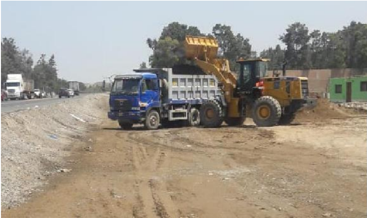
Figura 35. Carguío de desmonte para limpiar área a trabajar.
