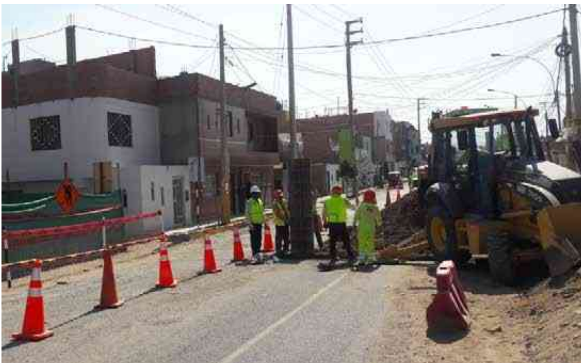
Figura 36 Señalización y cierre de vía para romper pista.
