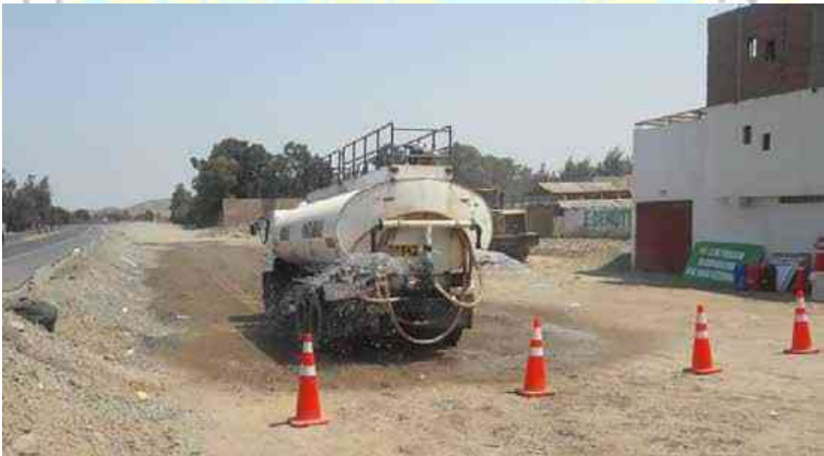
Figura 34. Riego de área a trabajar para evitar hacer polvos que pueda cubrir la visibilidad de la carretera y señalización para dar aviso al peatón.
