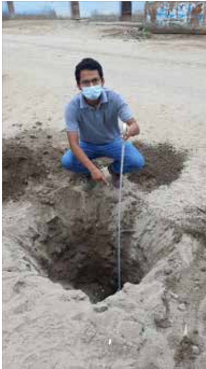
FOTO N° 1 INVESTIGADOR REALIZANDO CALICATA PARA RECONOCER LAS CARACTERISTICAS DEL TERRENO
