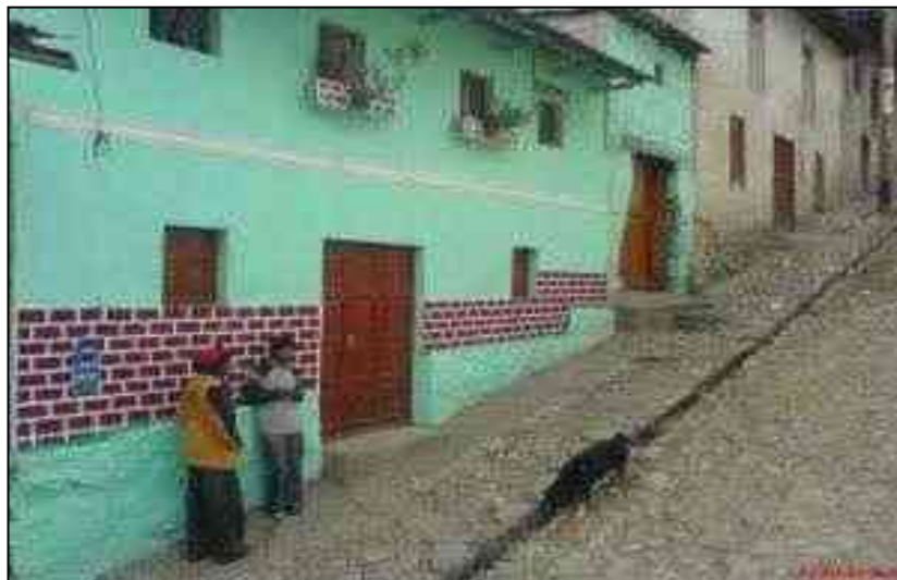
Figura 11. Vivienda Tipo en el distrito de San Damián
