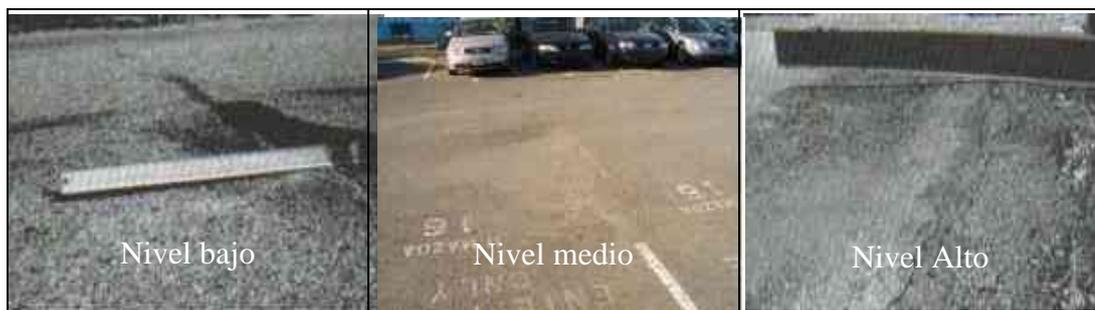
*Figura 4. Severidad de abultamiento y hundimiento.*
