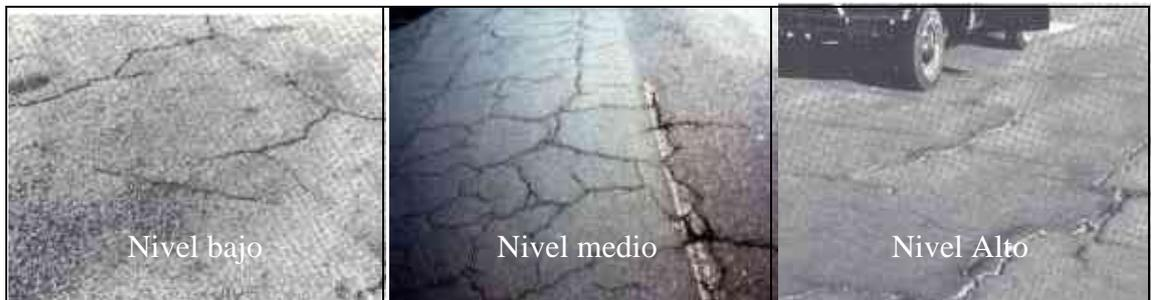
*Figura 3. Severidad de Fisuras en bloque*
