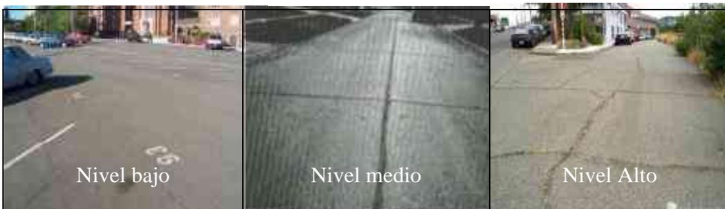
*Figura 7. Severidad de Fisura de borde.*
