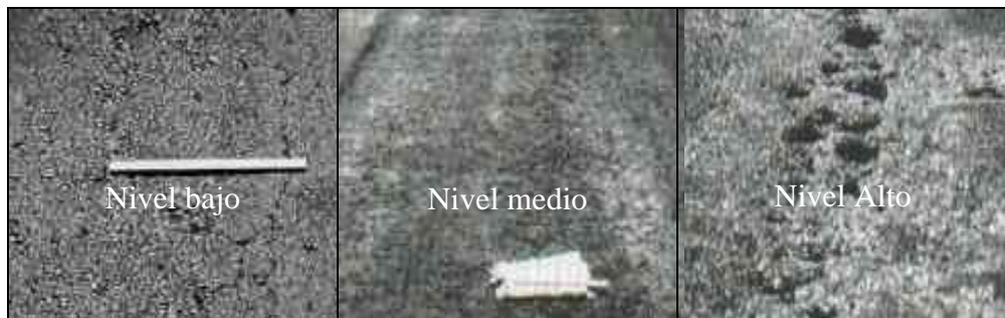
*Figura 17. Severidad de desprendimiento de agregados*
