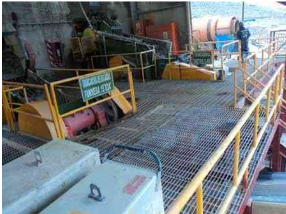
Foto N° 10: Vista de la plataforma del chancado primario con sus protecciones laterales
