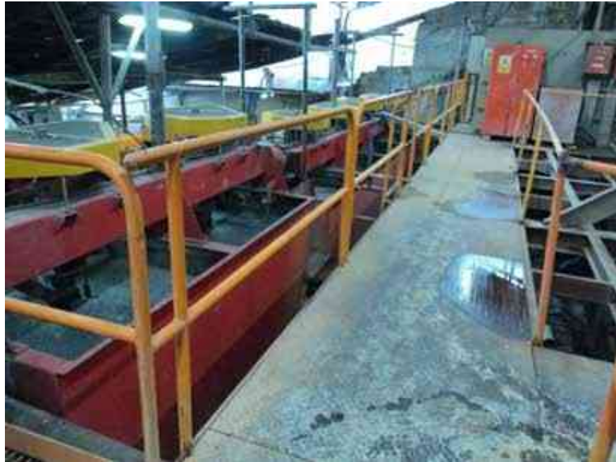
Foto N° 7: Barandas colocadas frente a la celda de flotación.
