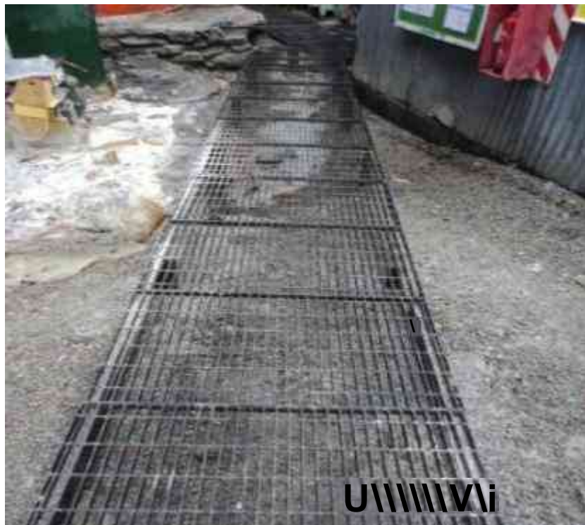
Foto N° 6: Pasadizo antideslizante colocado próximo a la de sala de reactivos.
