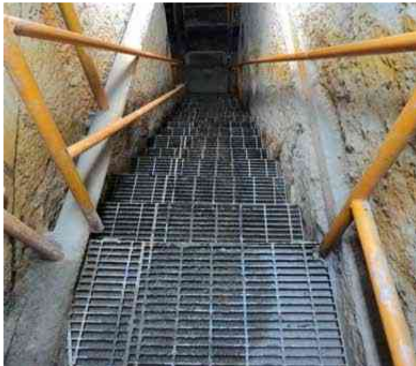
Foto N° 8: Vista de una escalera donde se ha instalado piso antideslizante y barandas.
