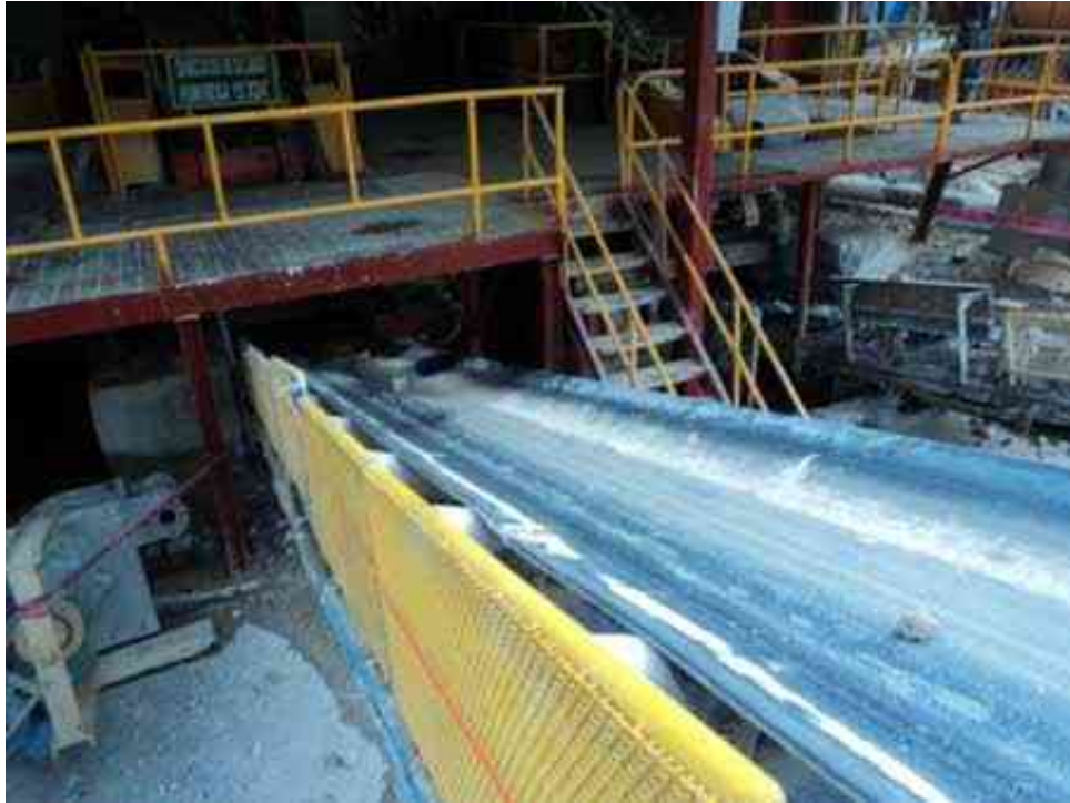
Foto N° 9: Vista de protección lateral de la faja N° 1 B
