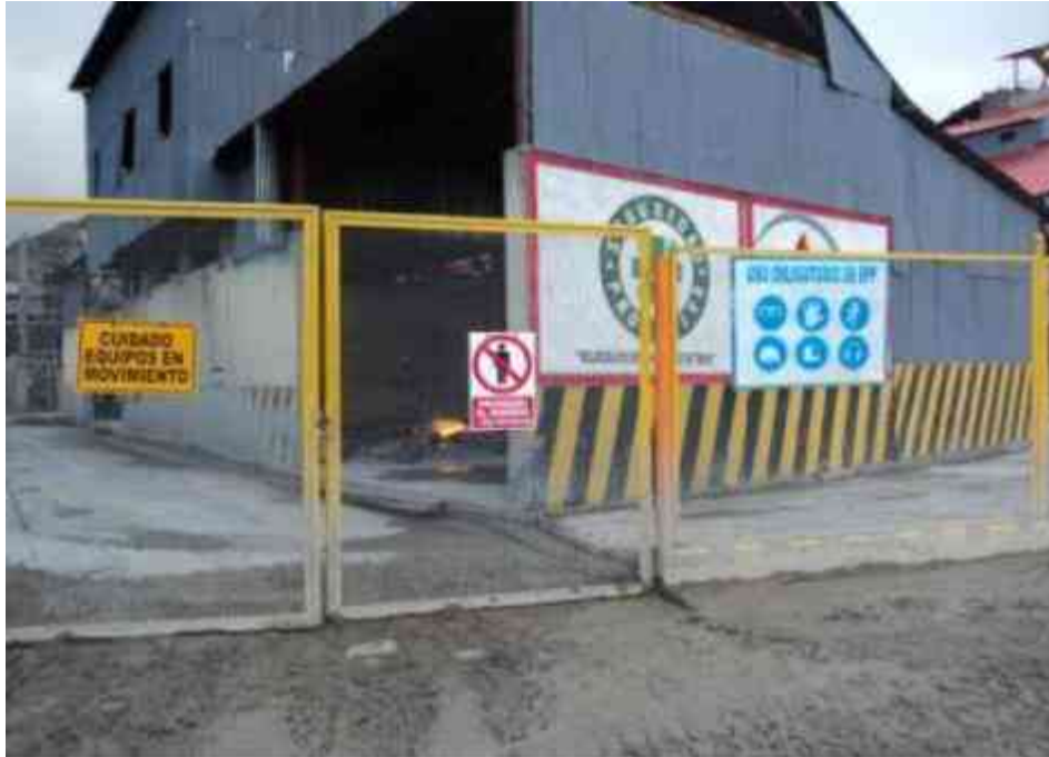
Foto N° 3: Señales preventivas, restrictivas y obligatorias ubicadas al ingreso a la planta concentradora, de acuerdo al código de colores anexo N° 11
