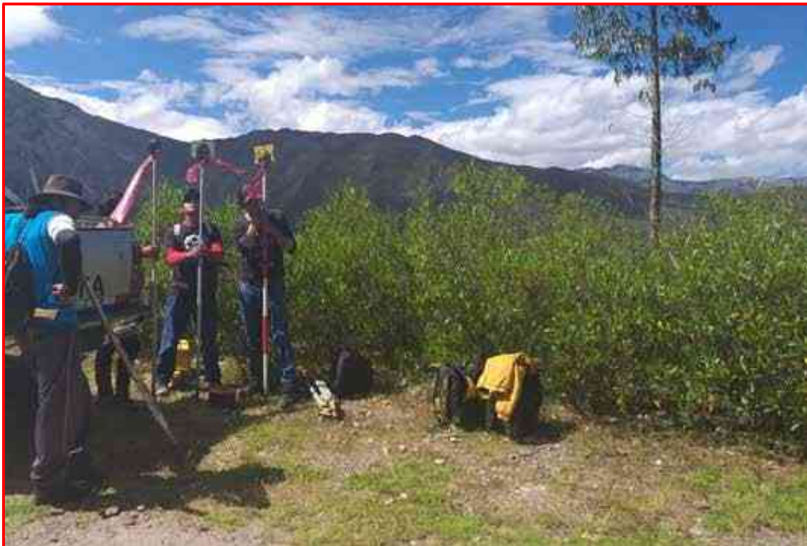
Se Observa a los Prismeros como Parte del Equipo técnico de Topografía que se utilizó en el trazo de la trocha.
