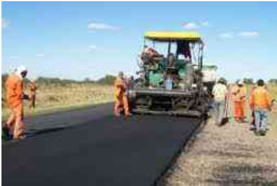
Figura 3. El servicio de la transitabilidad peatonal y vehicular en la pavimentación
