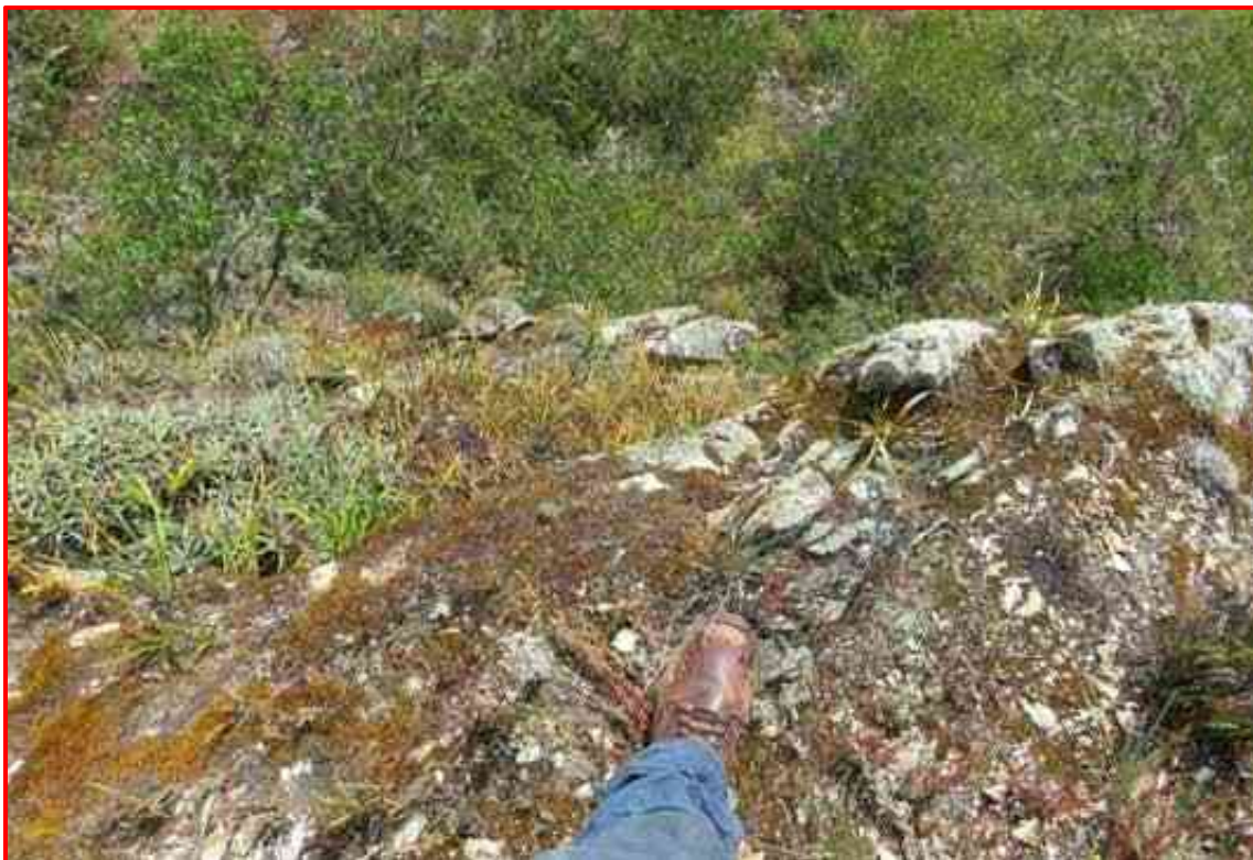
Vista por Donde Pasara la Trocha Carrozable, con Presencia de Roca fija.
