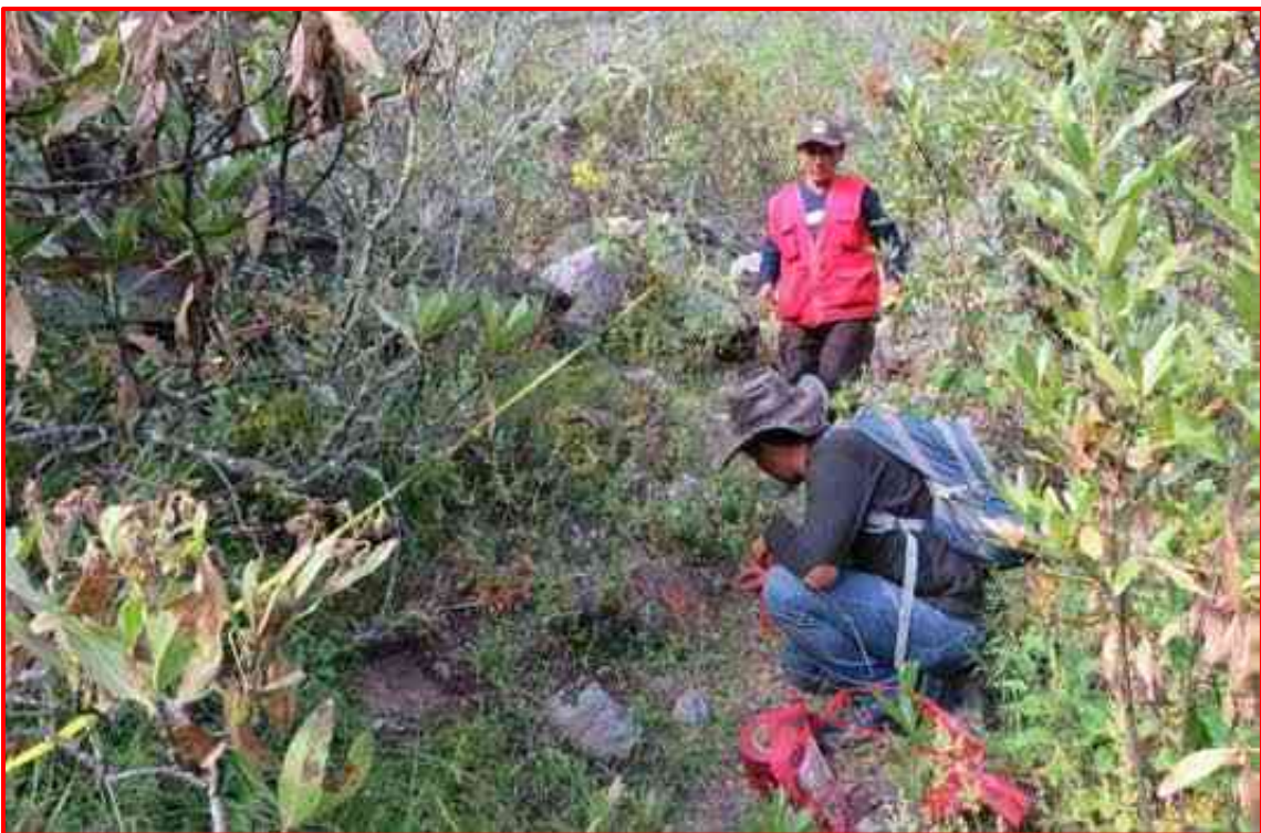
Especialista Realizando Trazo de Eje de Carretera.
