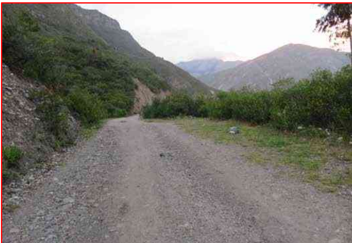
Examina el tramo inicial del trazo de la carretera Cancal - Matibamba, Progresiva 0+000 km
