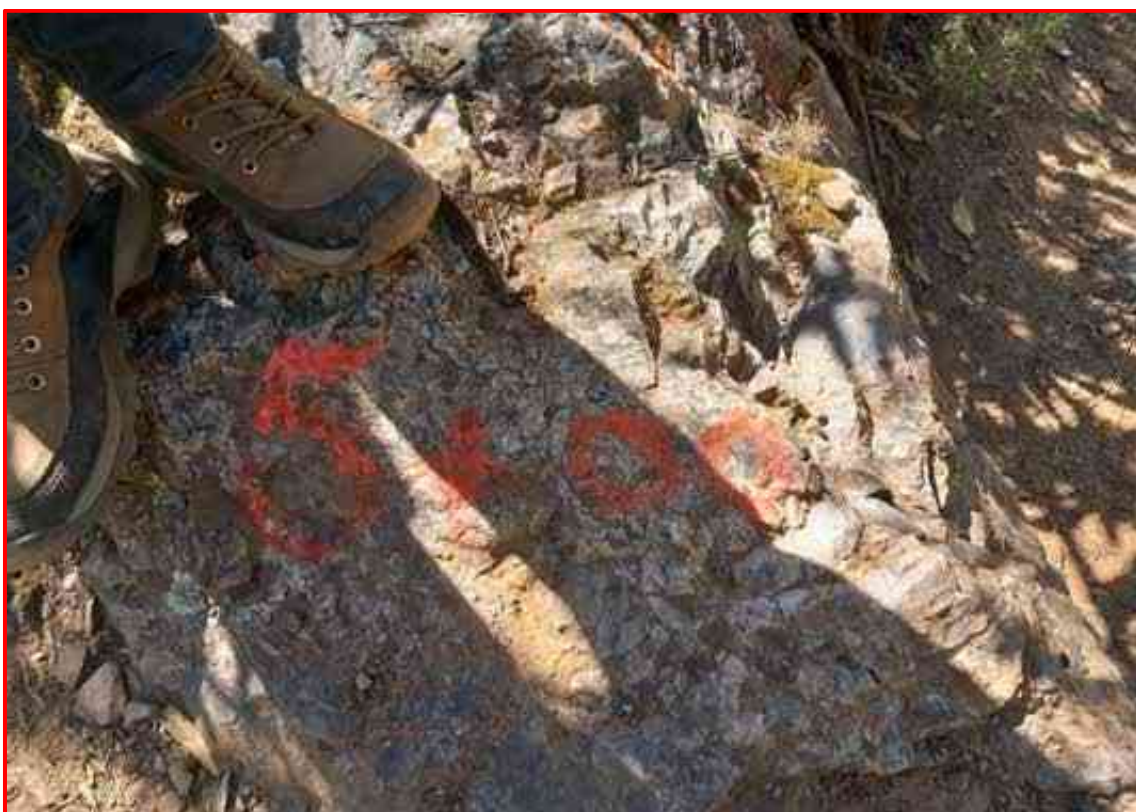
Se observa al personal Marcando la progresiva de la Trocha Carrozable, Progresiva KM 5+000
