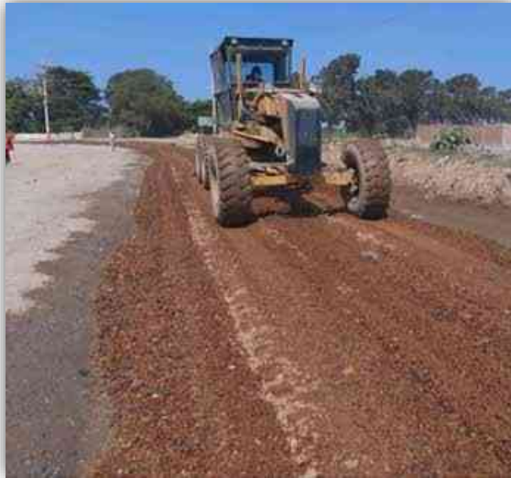
Figura 2. Servicio de transitabilidad vehicular y peatonal en caminos afirmados. Fuente: Transitabilidad vehicular y peatonal en caminos vecinales
