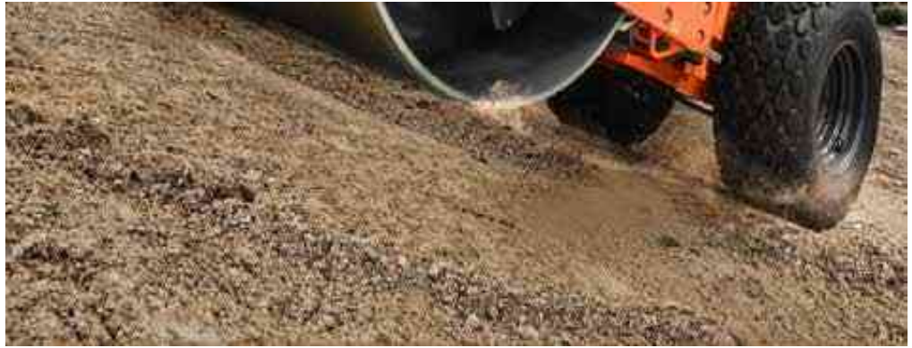
Figura 10: Trabajos para eficiencia vial
