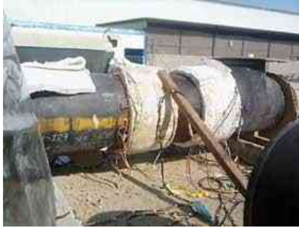
Figura 12. Proceso de calentamiento durante el T°T°.
