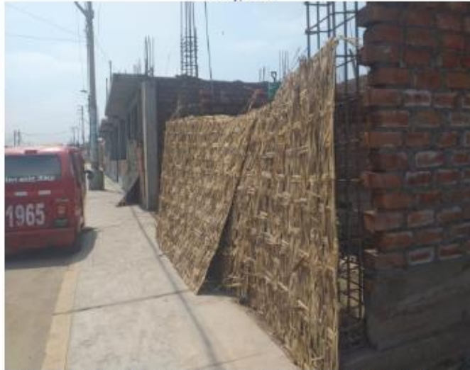
Fotografía 1: Vivienda en construcción en Av. Las delicias N° 717
