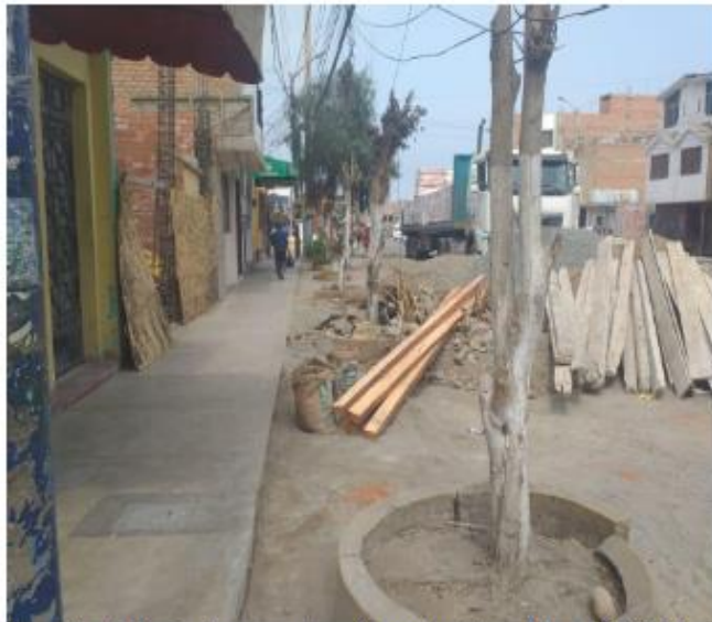
Fotografía 4: Vivienda en construcción en Av. Cruz Blanca N° 2082
