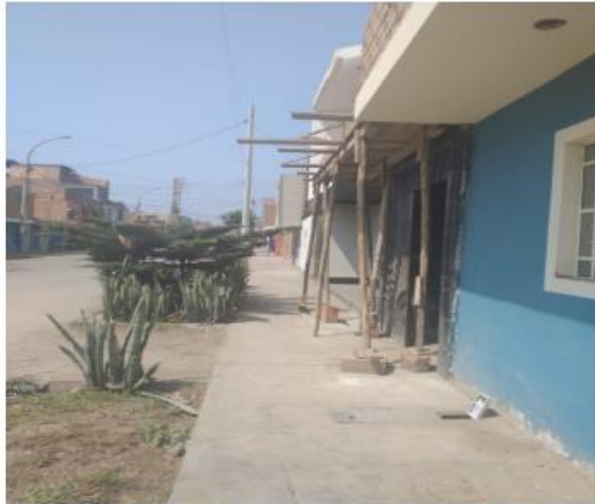
Fotografía 5: Remodelación de cochera en calle Ricardo Palma S/N (San Bartolomé)
