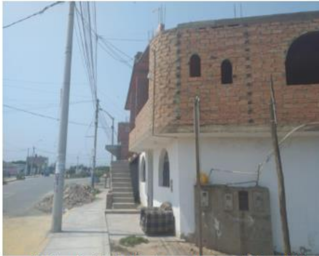
Fotografía 3: Ampliación de vivienda, segundo piso en Jr. Santa María N° 298
