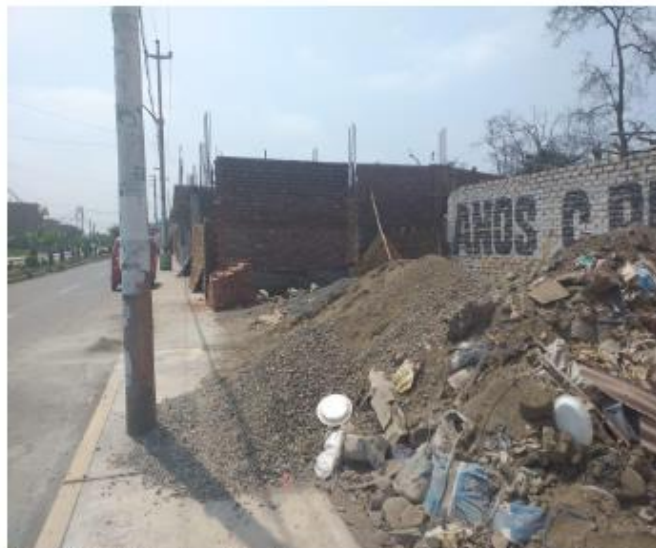
Fotografía 2: Vivienda unifamiliar en construcción en Av. Andrés Avelino Cáceres S/N
