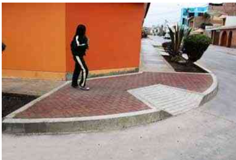
Fig N° 10 Construcción de veredas, rampas y sardineles
