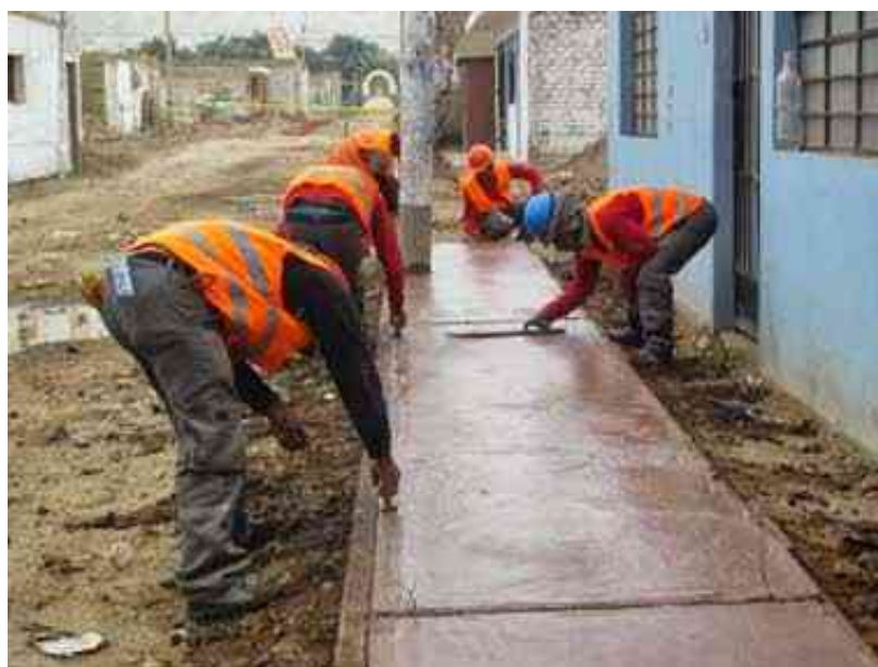
Fig N° 09 Construcción de veredas
