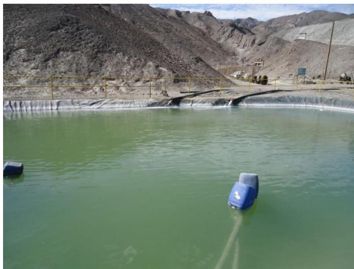
**Figura N° 10.** Poza de decantación y recirculación impermeabilizada
