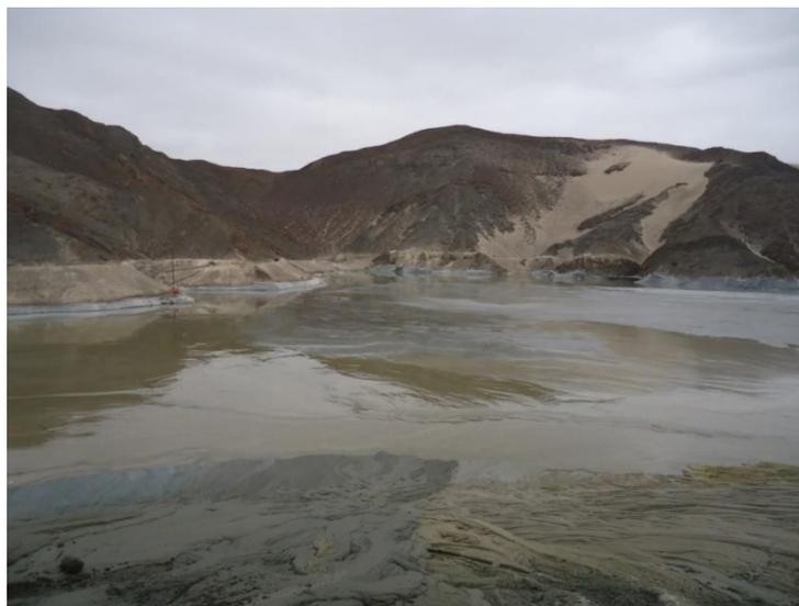
**Figura N° 9.** Cancha de relaves, método aguas abajo
